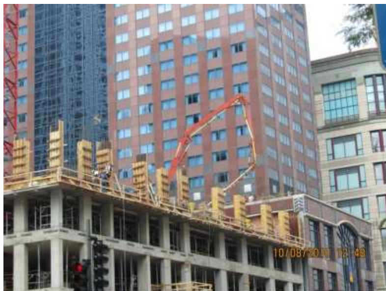
Укладка бетонной смеси с использованием распределительной стрелы (г. Чикаго, США, 2010 г.)
