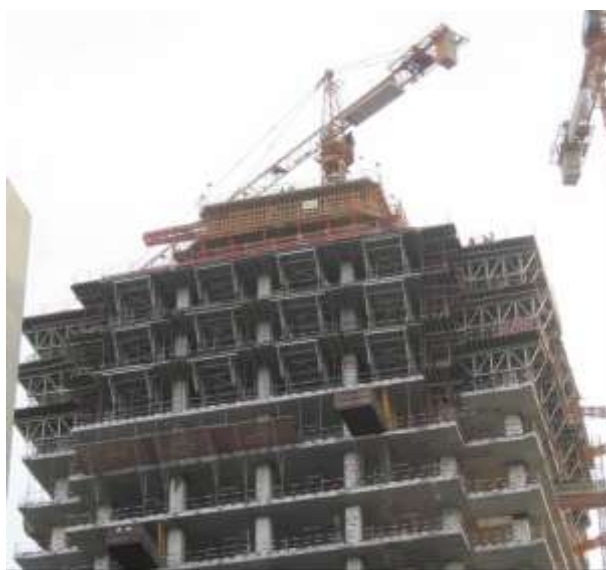
Технологические площадки фасадов высоток (г. Дубай, 2008 г.)
