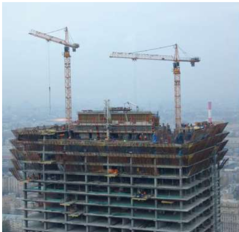
Возведение монолитных конструкций с использованием самоподъемного крана (г. Москва, Россия, 2008 г.)
