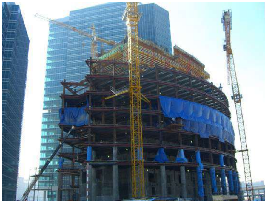
Установка ветрозащитных ограждений на фасаде высотного здания (г. Москва, Россия, 2007 г.)
