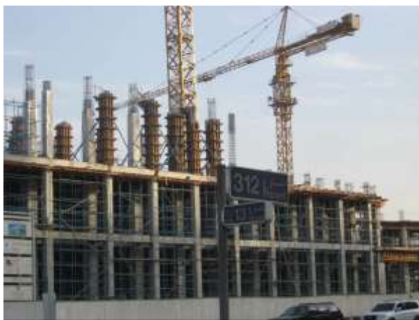
Возведение здания высотой 20 этажей с применением традиционных опалубочных систем (г. Дубай, 2008 г.)
