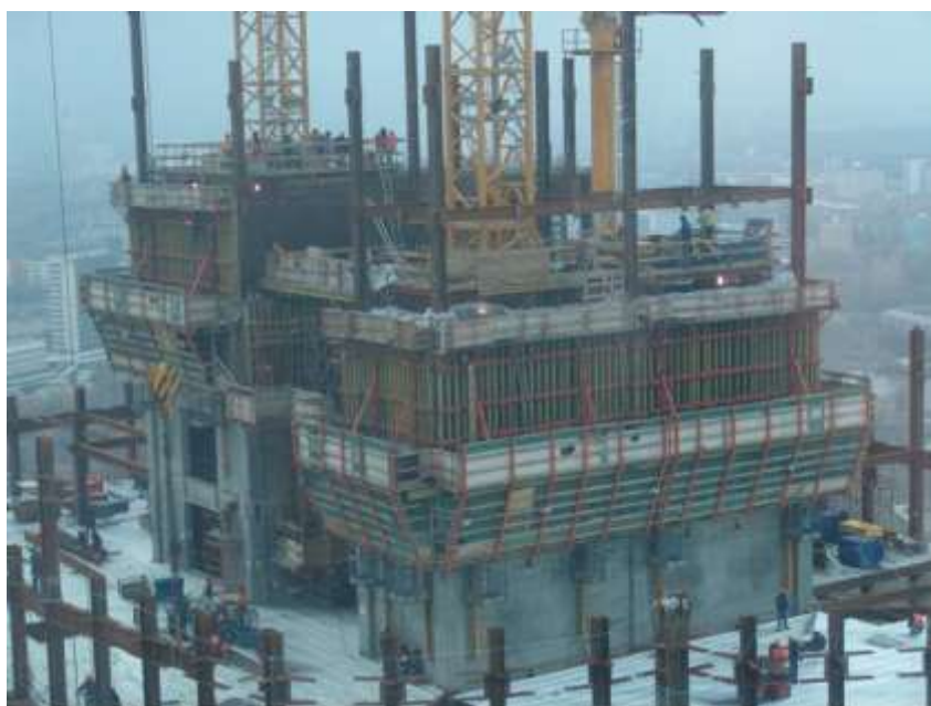
Самоподъемная опалубка при строительстве небоскреба в г. Москва (Россия, 2008 г.)
