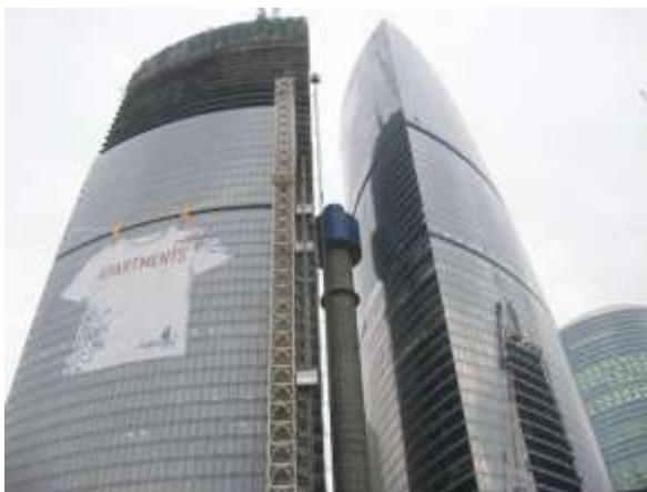
Совмещение работ по устройству каркаса и фасада здания (г. Москва, Россия, 2008 г.)
