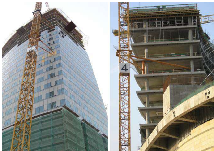
Крепление приставного башенного крана к каркасу здания (г. Варшава, Польша, 2007 г.)
