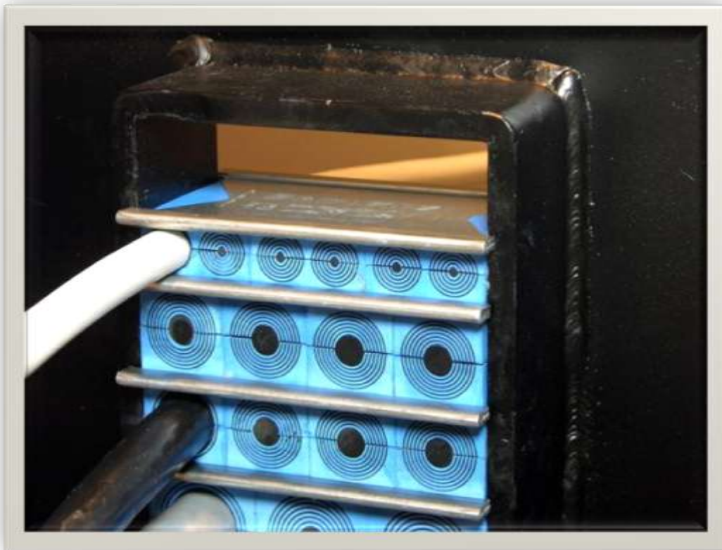
4. Компрессионный блок, действующий по принципу распорки, позволяет надежно зафиксировать модули в раме.
