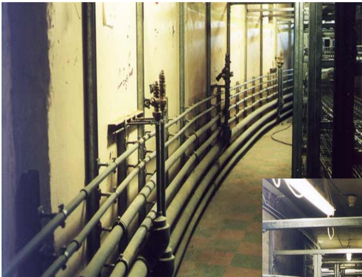
Труба диаметром до 110 мм для горячего водоснабжения
