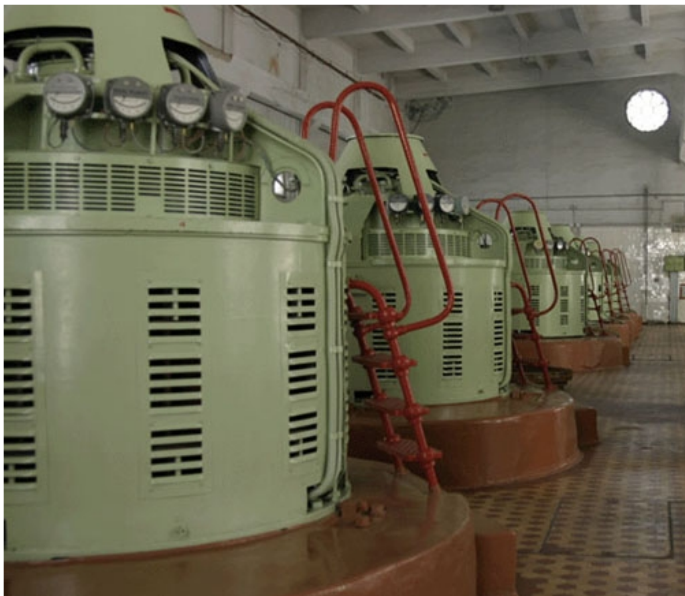
Рис. 4.6. Машинный зал насосной станции II-го подъема с насосами типа В: а – насосы; б – электродвигатели
