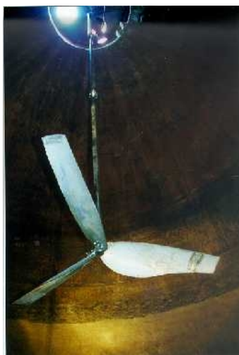
Рис. 5.6. Мешалка Scba (ABS), установленная в метантенке Ново-Люберцкой СА
