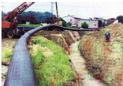
Рис. 2.24 Фрагмент ремонта традиционным способом с рытьем траншеи с использованием трубной плети «Спиро» диаметром 1200 мм
