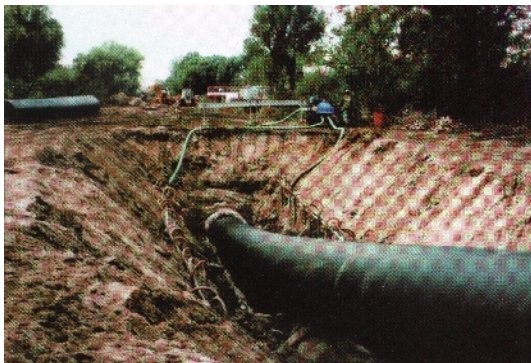
Рис. 2.23. Фрагмент бестраншейного ремонта с использованием трубной плети «Спиро» диаметром 1100 мм
