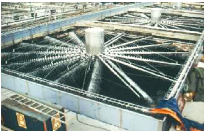
Рис. 4.33. Биофильтры прямоугольной формы в плане с плоскостной загрузкой с лотковой системой распределения сточной воды.
