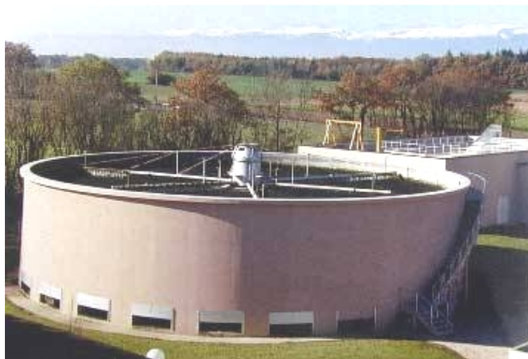
Рис. 4.34. Биофильтры круглой формы в плане с плоскостной загрузкой с реактивным орошителем.
