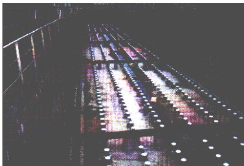
Рис. 4.17. Общий вид аэрационной системы с тарельчатыми диффузорами
