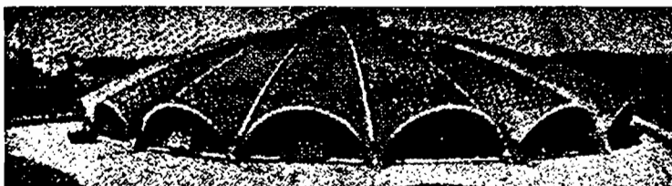
Рис. 8.32. Волнистый стеклопластиковый купол диаметром 18 м над зданием рынка в Сент-Уан (Франция)
