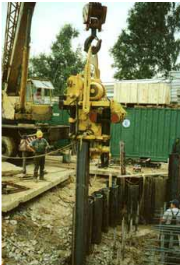
Рис. 11.2 . Выполнение ограждения из шпунта Ларсона методом вибропогружения
