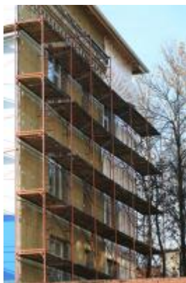
Рис.13.12. Термоизоляция фасада
