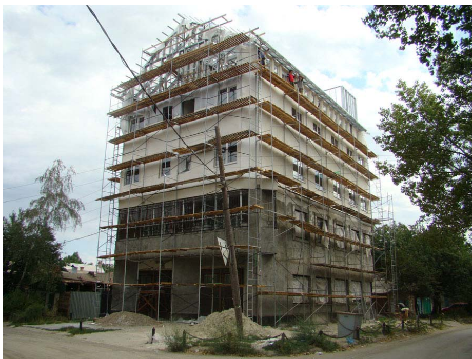
Рис.13.2. Надстройка здания с использованием легкого стального каркаса
