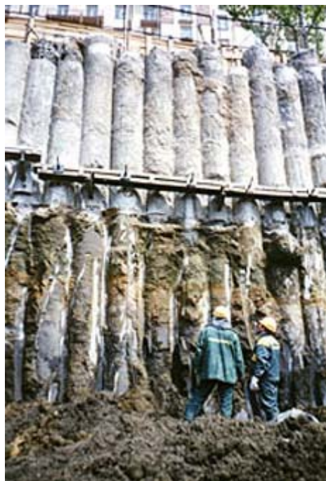
Рис. 11.8 Ограждение из буросекущихся свай, укрепленное стержневыми анкерами.
