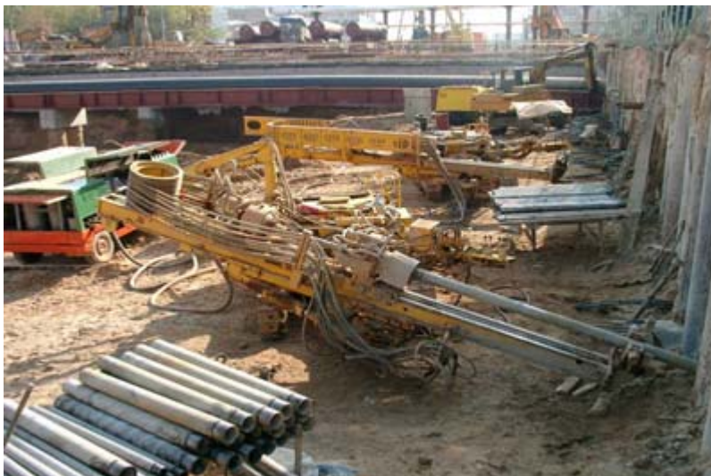
Рис.11.10. Устройство грунтовых анкеров
