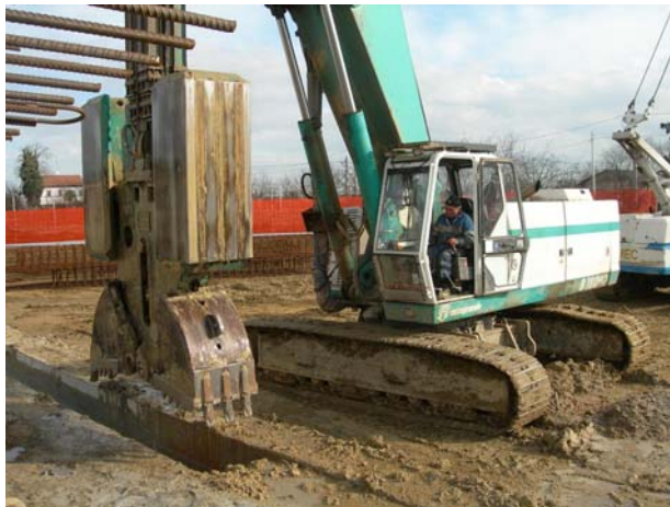
Рис.11.1. Разработка траншеи грейферным экскаватором под защитой глинистой суспензии (раствора)
