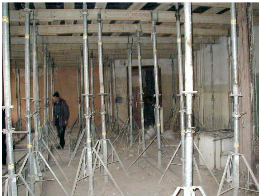
Рис.13.1 Демонтаж элементов покрытия
