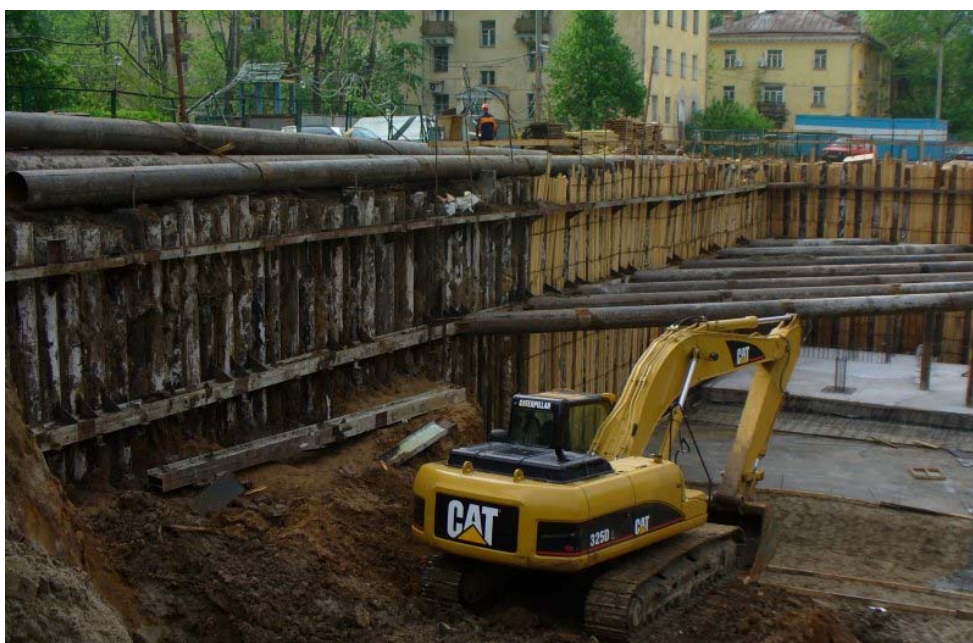
Рис. 11.1. Ограждение котлована из труб
