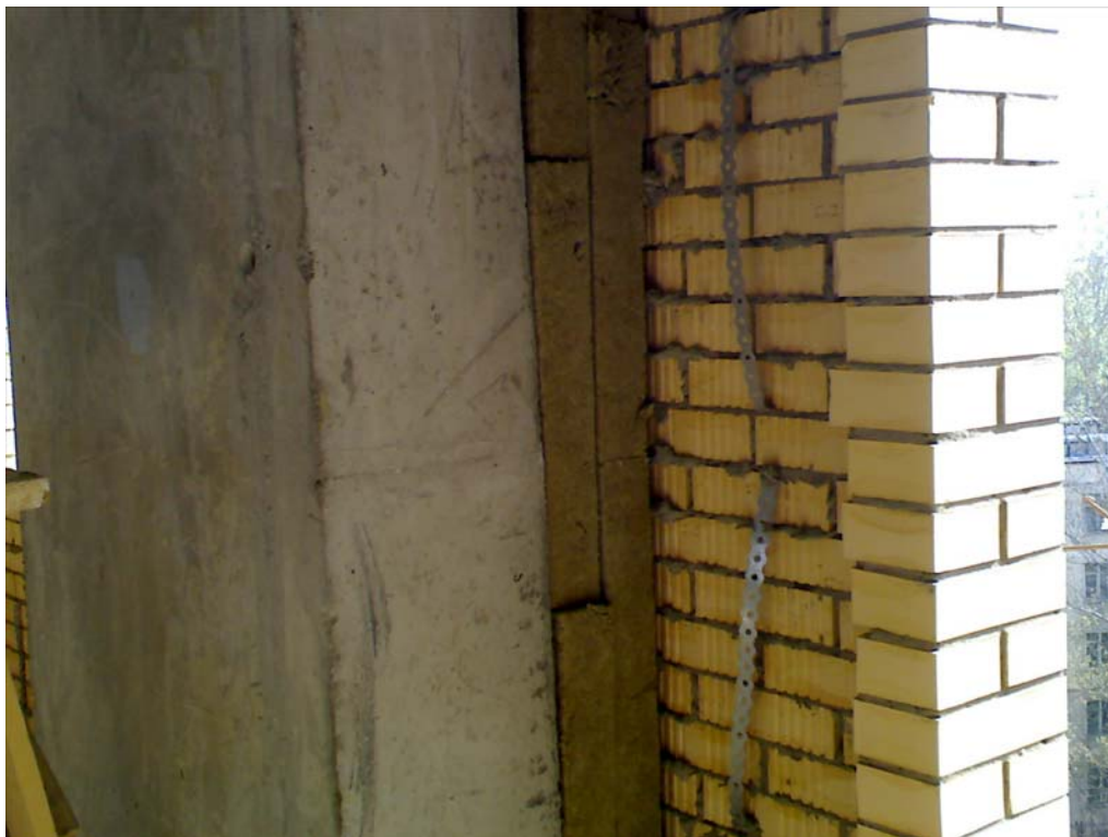
Рис.11.23. Фрагмент облицовки стены кирпичом на строительном объекте по адресу: Проспект Вернадского, корпус 73-1, г. Москва.
