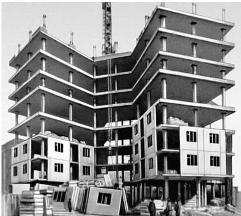
Рис. 9.6 Общий вид строительной площадки
