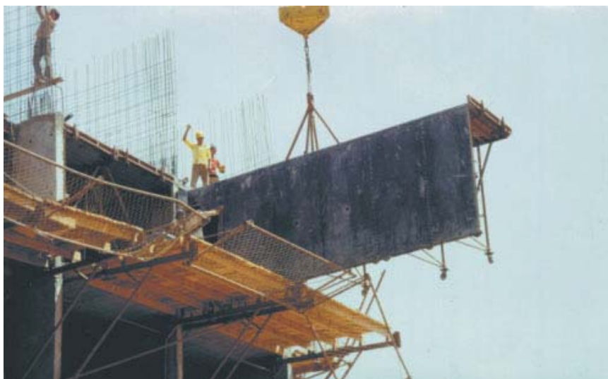
Рис. 11.20. Монтаж опалубки
