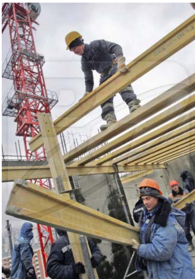
Рис.11.15. Устройство опалубки на междуэтажных перекрытиях
