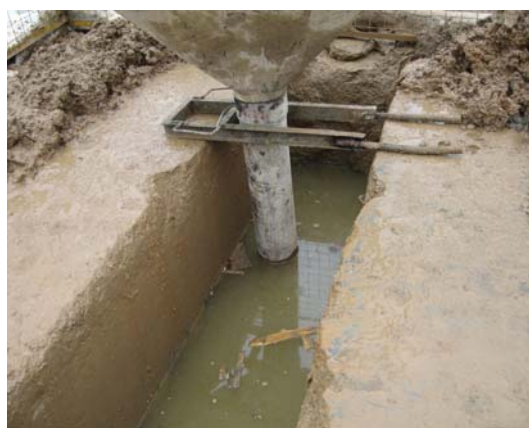
Рис. 11.2. Бетонирование методом вертикально перемещающейся трубы (ВПТ)
