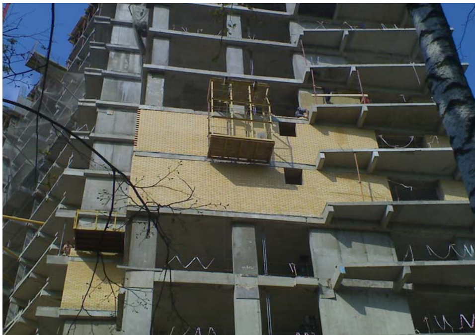
Рис. 11.22. Организация работ по облицовке железобетонных стен кирпичом
