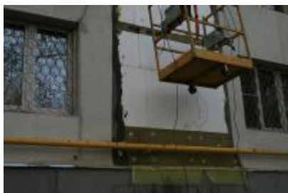
Рис.13.12. Термоизоляция фасада
