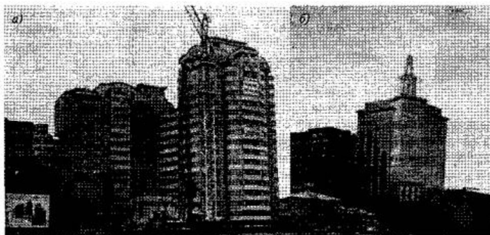
Рис. 14.15. Общий вид жилого комплекса первой очереди строительства (а) и каркасно-панельного здания с перепрофилированием в банковско-офисное (б)
