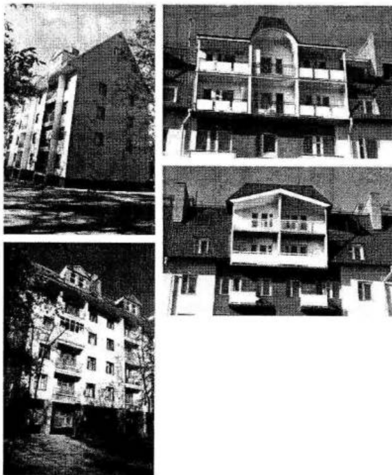
Рис. 10.62. Варианты надстройки жилых 4-этажных зданий мансардными этажами (г. Лыткарино, Московская область)
