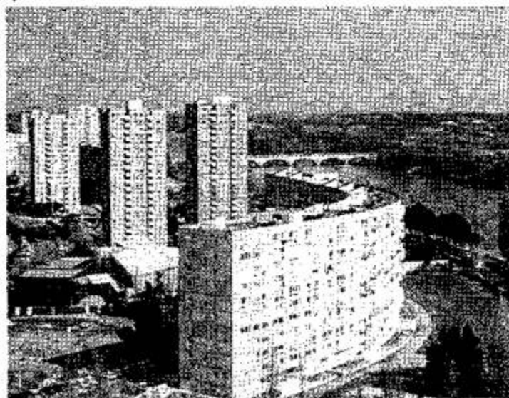
Рис. 10.9. 16-этажный крупнопанельный жилой дом послевоенной постройки, подлежащий сносу (а); реконструкция с уплотнением застройки и возведением новых зданий (б). Франция, г. Нант
