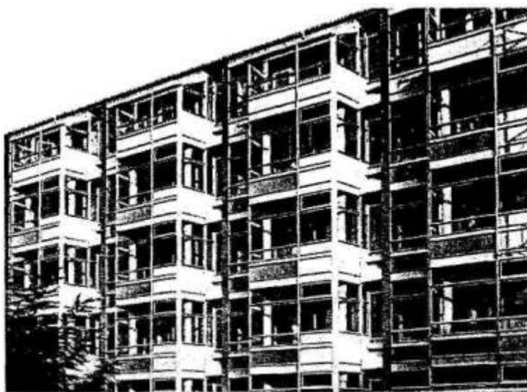
Рис. 10.5. Пристраиваемые объемы (лоджии) из элементов полной готовности
