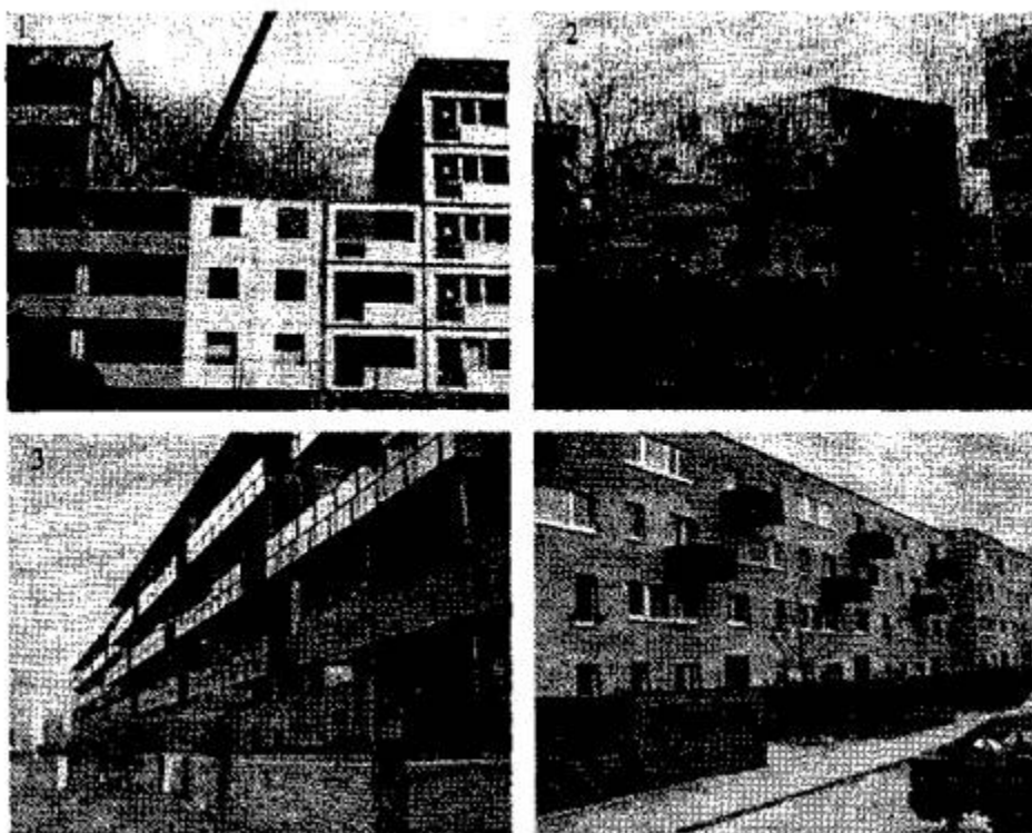
Рис. 10.3. Реконструкция крупнопанельных зданий в г. Лейфенфельде (ФРГ)
