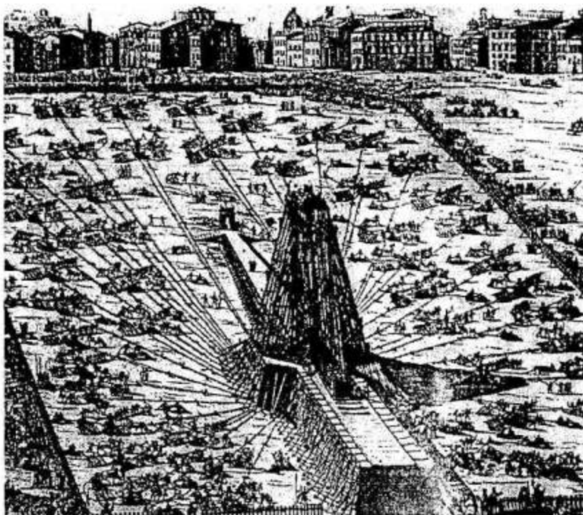
Рис. 12.1. Общий вид площади с приспособлениями для перемещения обелиска (Рим, 1586 г.)
