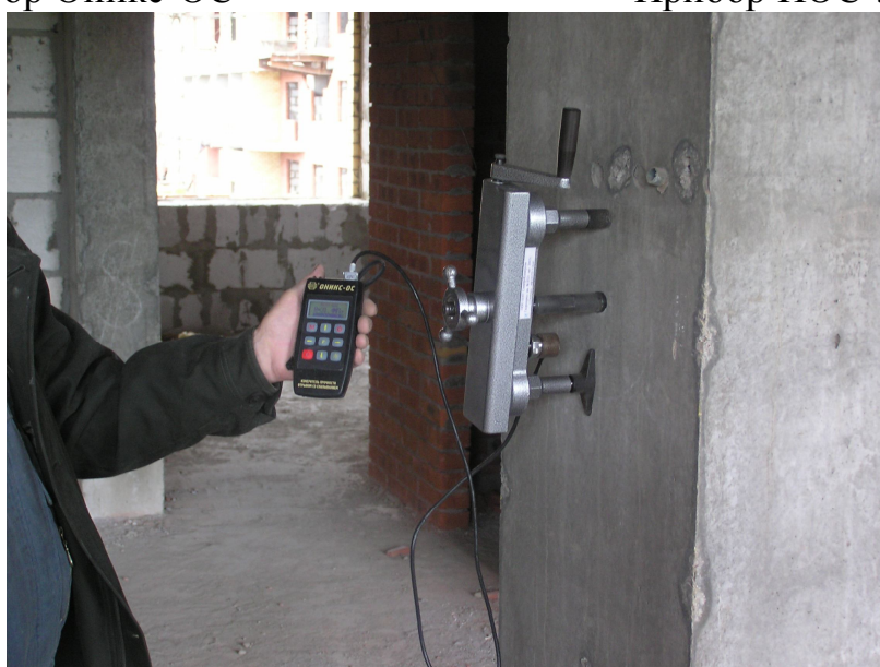
Определение прочности бетона методом локальных разрушений с помощью прибор Оникс-ОС
