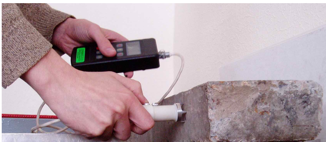
Определение прочности бетона ударно-импульсным методом с помощью прибора Оникс-2.3
