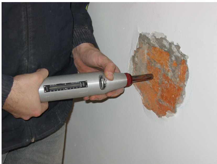
Определение прочности кирпича методом упругого отскока с помощью прибора Молоток Schmidt
