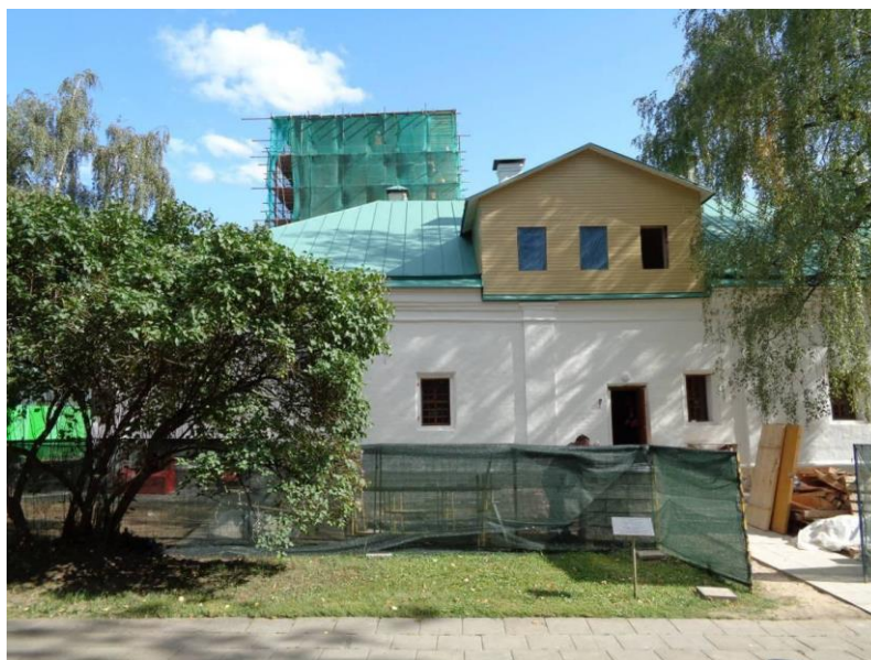
Рис. 12. Больничные палаты. Фрагмент фасада здания (сентябрь 2018 г.) [1]
