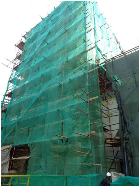
Рис. Здание №35. Иоасафовская башня (на реконструкции). Вид на фасад башни. (сентябрь 2018 г.) [2]
