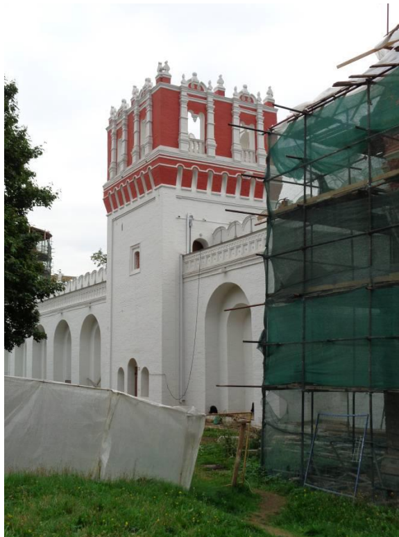
Рис. Здание №38. Покровская башня. Вид на фасад башни. (сентябрь 2018 г.) [2]
