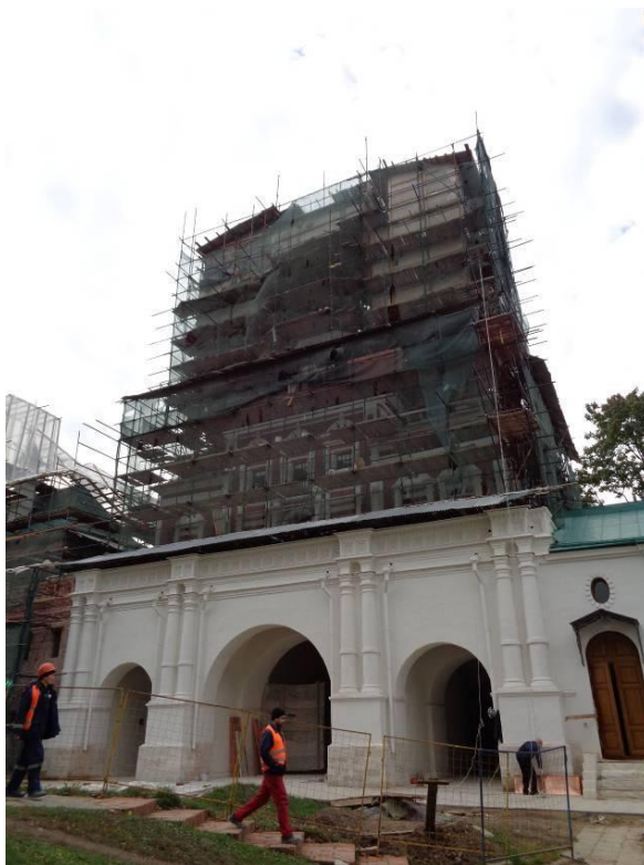
Рис. 7. Покровская церковь Южных ворот (на реконструкции) Вид фасада здания (сентябрь 2018 г.) [1]
