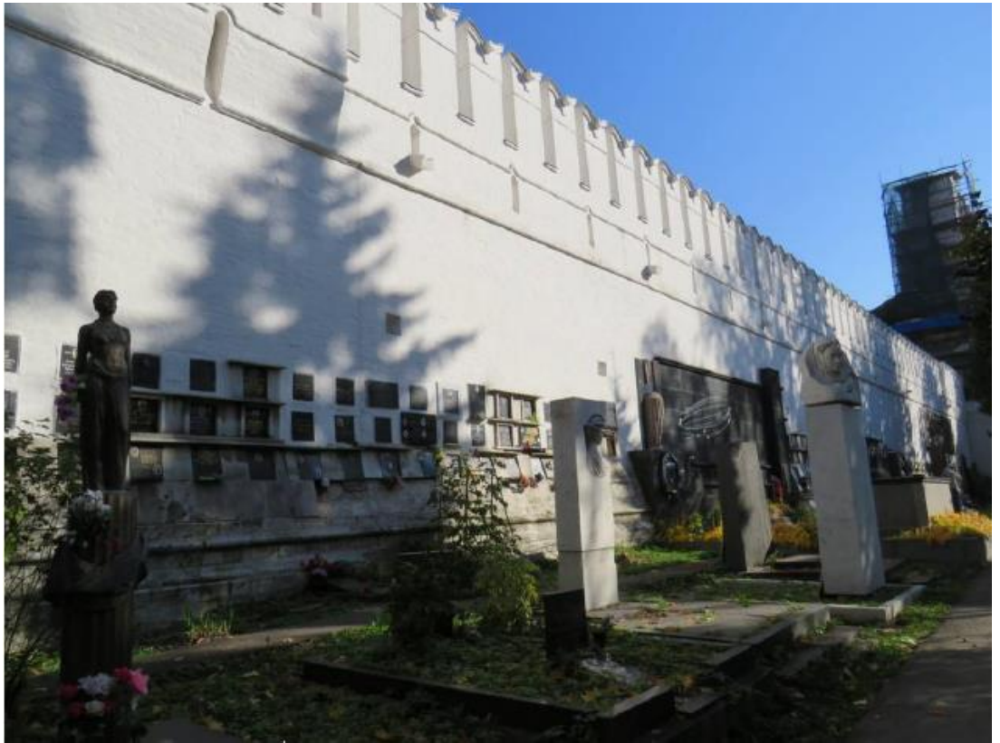
Рис. 26. Общий вид на прясло между Покровской и Предтеченской башнями. (сентябрь 2018 г.) [2]
