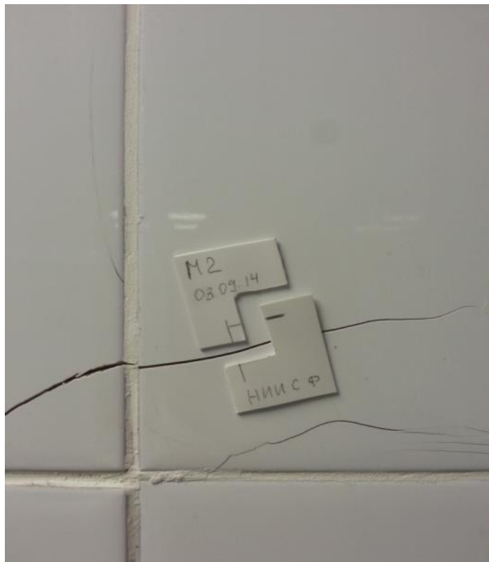
Рис. П2 Пластинчатые маяки на трещине.
