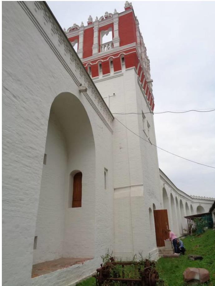
Рис. Здание №41. Затрапезная башня. Вид на фасад башни. (сентябрь 2018 г.) [2]
