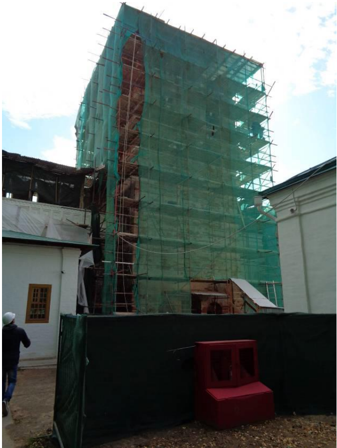
Рис. Здание №36. Швальная башня(на реконструкции). Вид на фасад башни. (сентябрь 2018 г.) [2]
