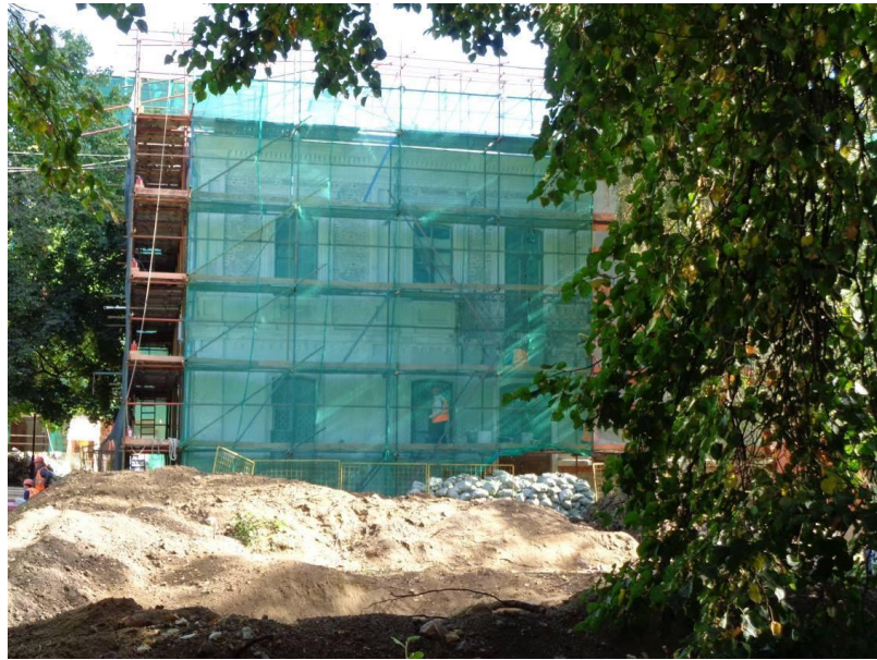
Рис. 14. Училище Филатьевское (на реконструкции). Вид дворового фасада здания (сентябрь 2018 г.) [1]
