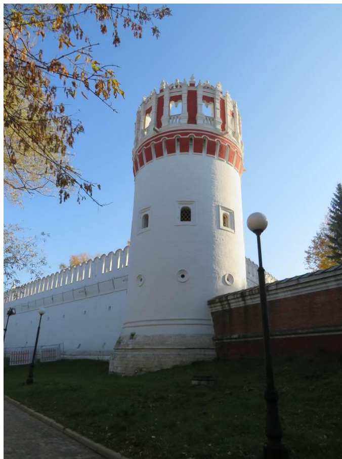
Рис.Здание №40. Сетунская башня. Вид на фасад башни. (сентябрь 2018 г.) [2]
