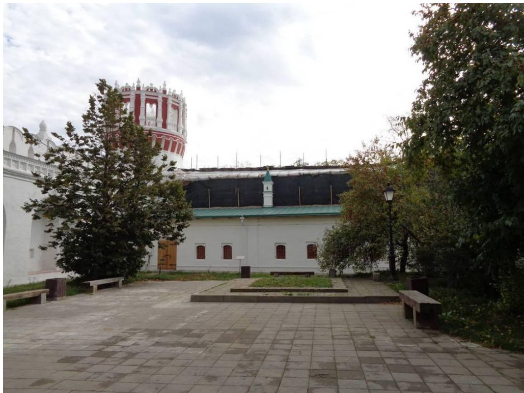
Рис. 17. Стрелецкая караульня Никольской башни. Вид фасада здания (сентябрь 2018г.)[1]
