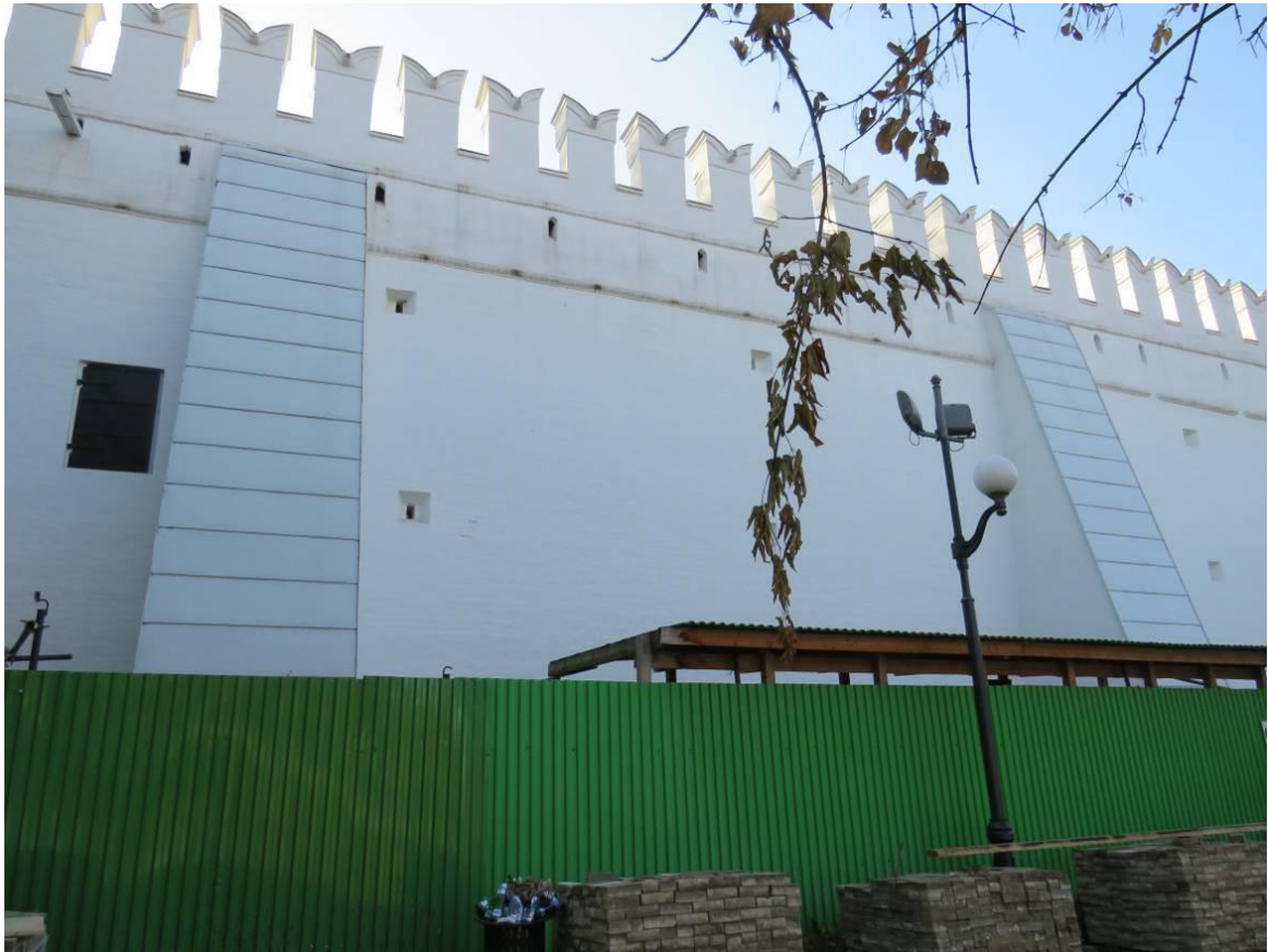
Рис. 30. Общий вид на прясло между Саввинской и Напрудной башнями. (сентябрь 2018 г.) [2]
