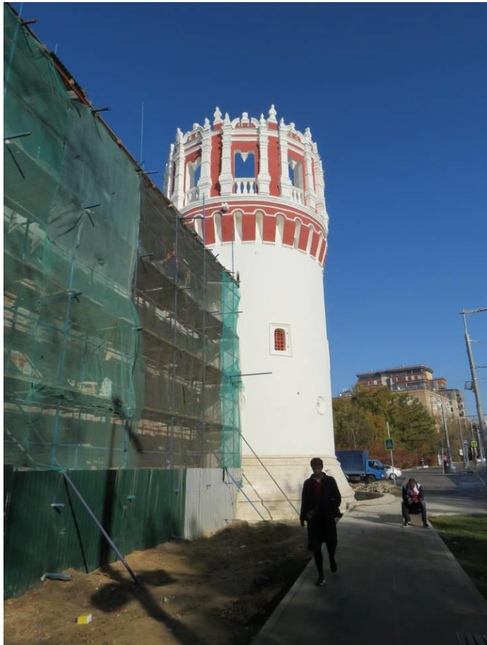
Рис.22. Общий вид на прясло между Никольской и Иосафовской башнями. (сентябрь 2018 г.) [2]
