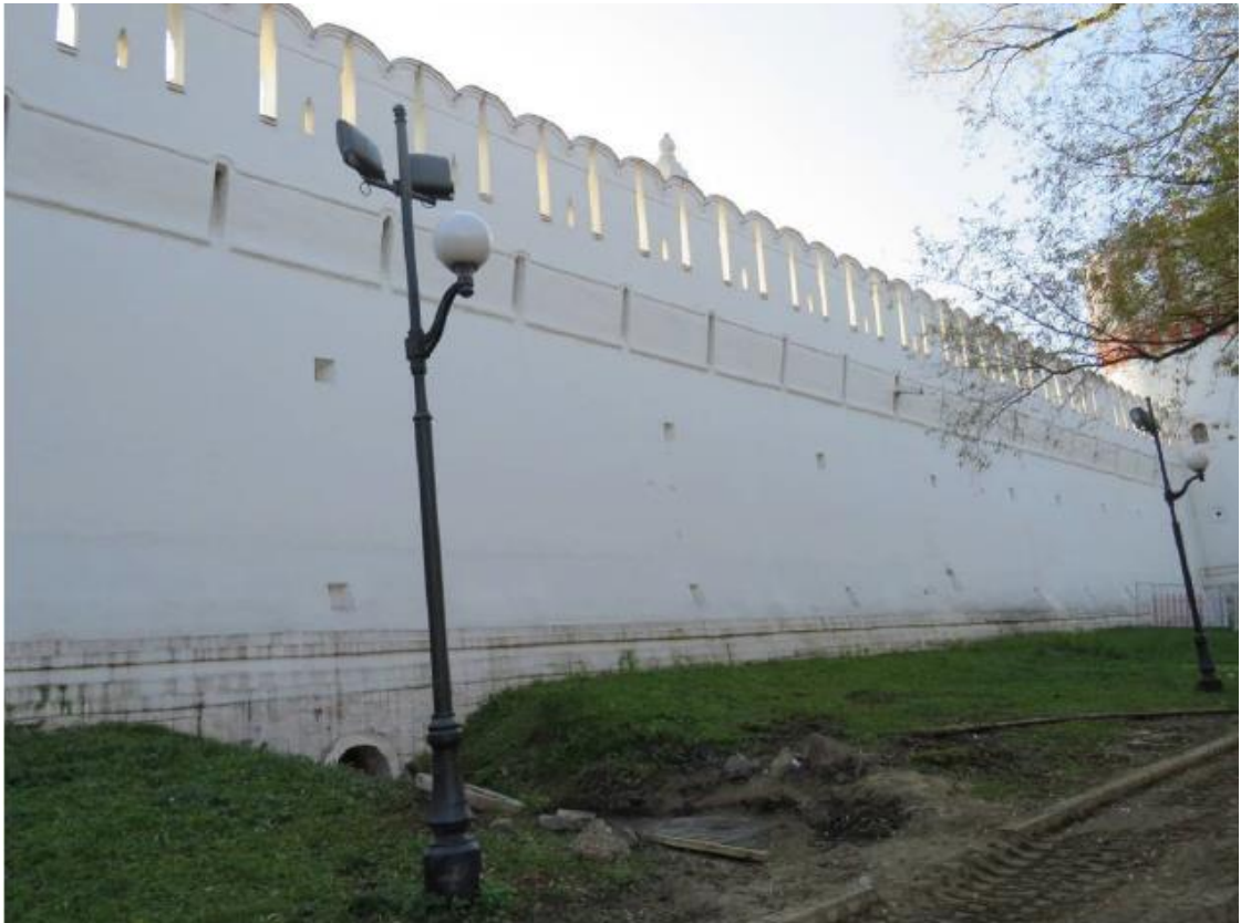
Рис. 28. Общий вид на прясло между Сетуньской и Затрапезной башнями. (сентябрь 2018 г.) [2]
