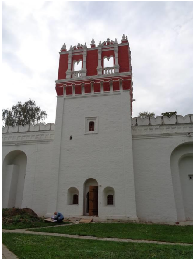
Рис. Здание №39. Предтеченская башня. Вид на фасад башни. (сентябрь 2018 г.) [2]
