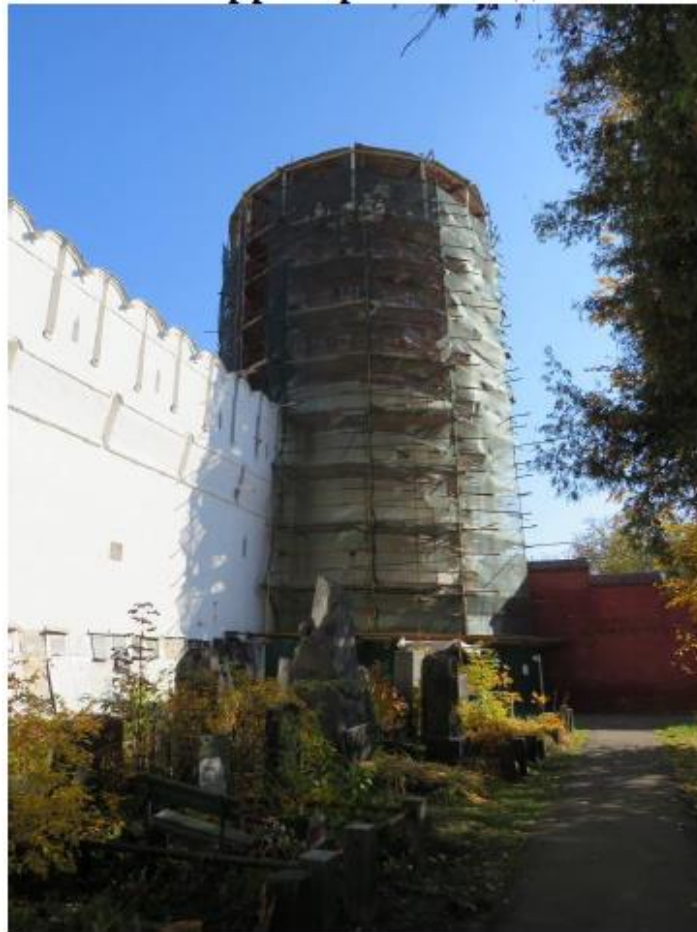
Рис. Здание №37. Чеботарная башня (на реконструкции). Вид на фасад башни. (сентябрь 2018 г.) [2]
