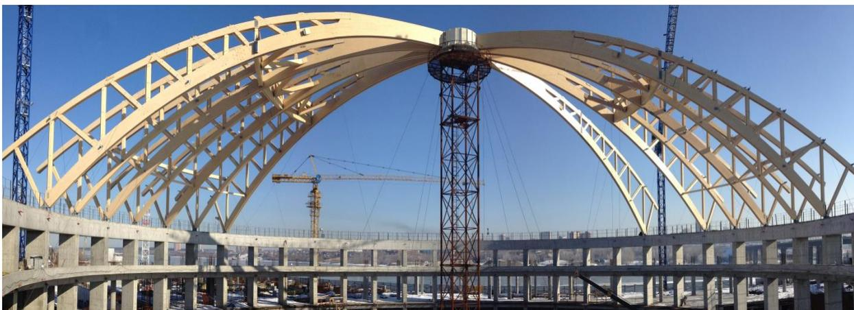
*Рис. 7.3.4. Купольное покрытие диаметром 95 метров с каркасом из клееной древесины в г. Новосибирске. Проект ЦНИИСК им. В.А.Кучеренко*
