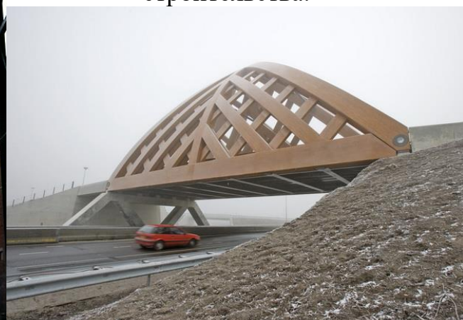
Рис. 1.6. Моста над дорогой в Нидерландах
