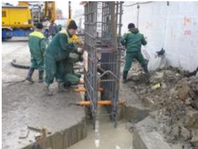
Рис. 8.10. Установка арматуры
