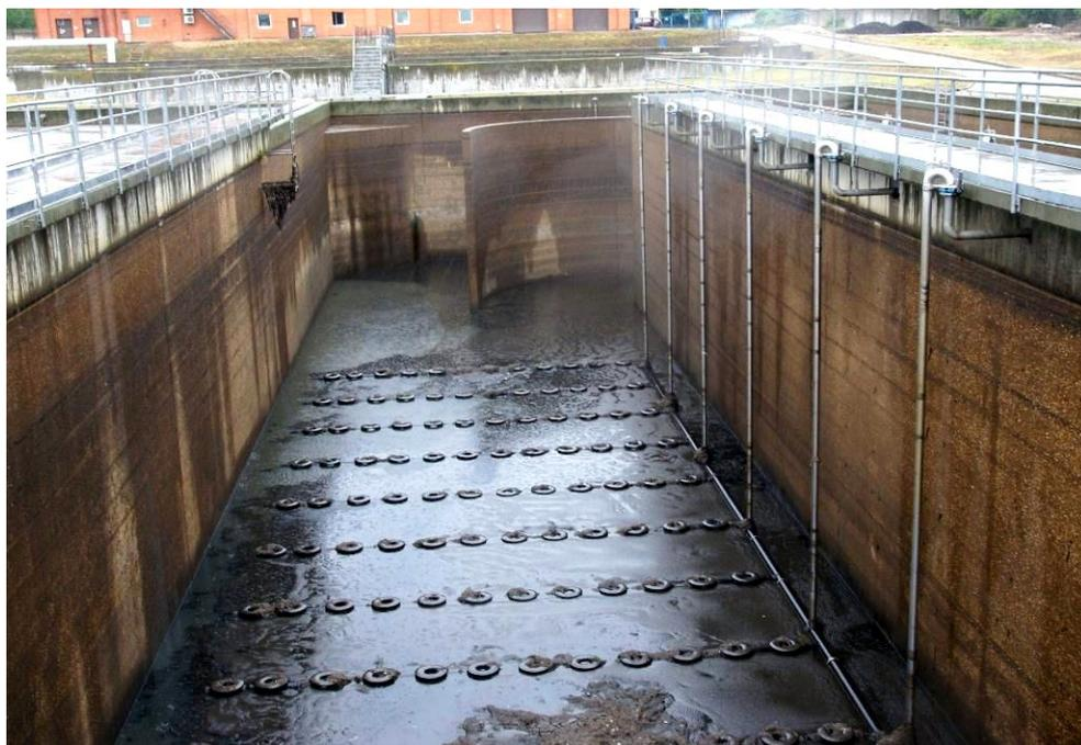
**Рис.6.4.** Коридор опорожненного аэротенка (зона аэрации)
