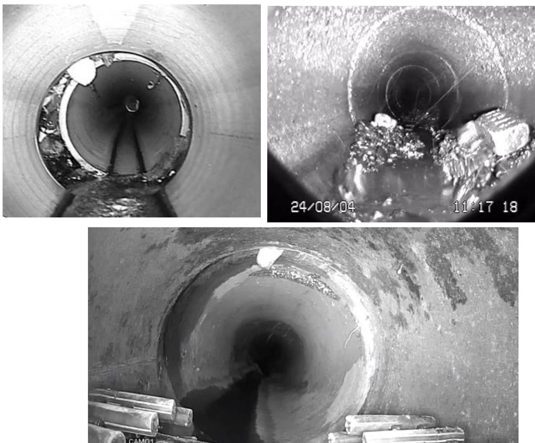
**Рис. 5.5.** Вид поврежденных участков трубопроводов, полученных с помощью ТВ-диагностических комплексов
