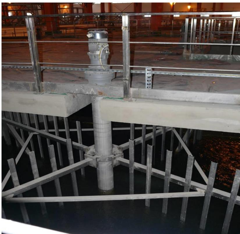
**Рис.3.1.** Низкоградиентная механическая мешалка, установленная в камере хлопьеобразования
