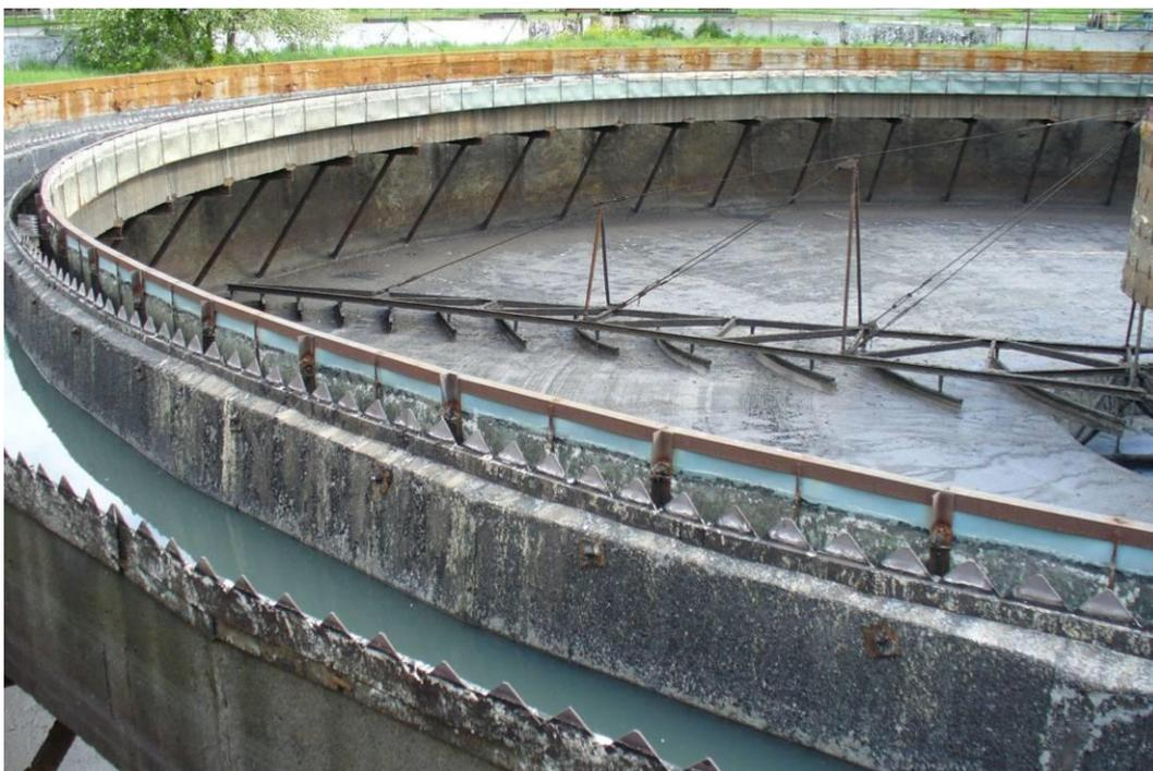
**Рис. 6.3.** Первичный радиальный отстойник (опорожнен для ремонта)
