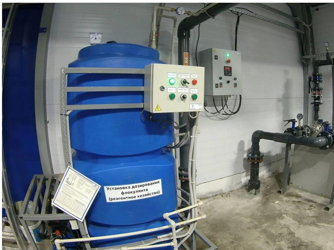
**Рис. 3.6.** Реагентное хозяйство – расходная емкость и узел дозирования
