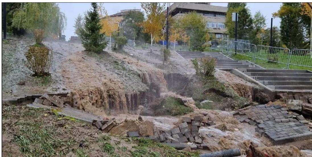
**Рис.5.6.** Авария на канализационном коллекторе с изливом сточных вод на поверхность земли
