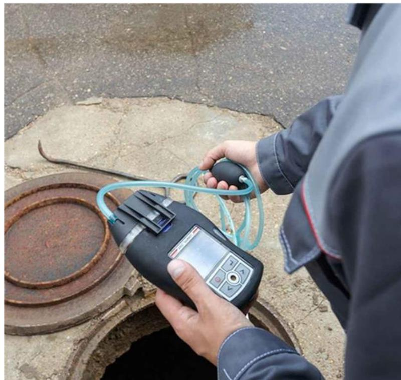
*Рис. 7.2. Проверка колодца (камеры) на содержание ядовитых и взрывоопасных газов с использованием газоанализатора.*
