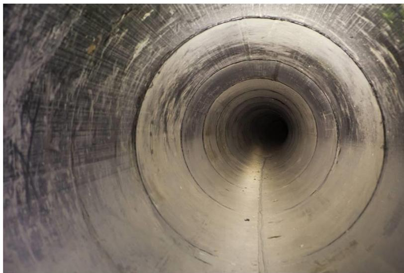
**Рис. 5.4.** Визуальный контроль построенного коллектора, проводимый с помощью теледиагностического комплекса.
