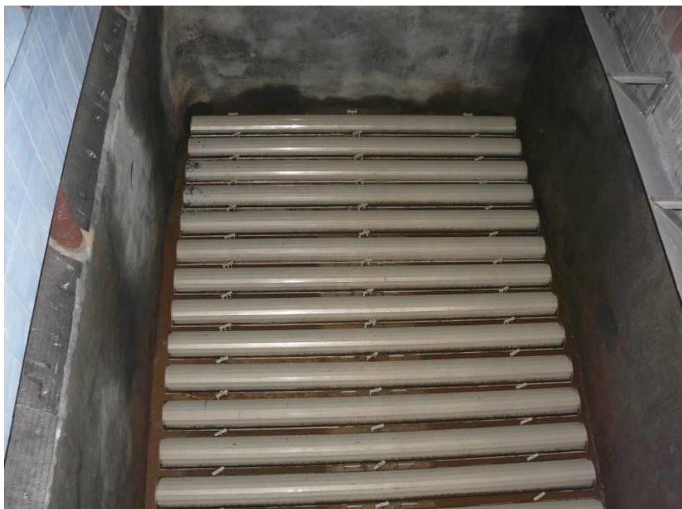
**Рис. 3.3.** Щелевая дренажно-распределительная система скорого фильтра для водовоздушной промывки
