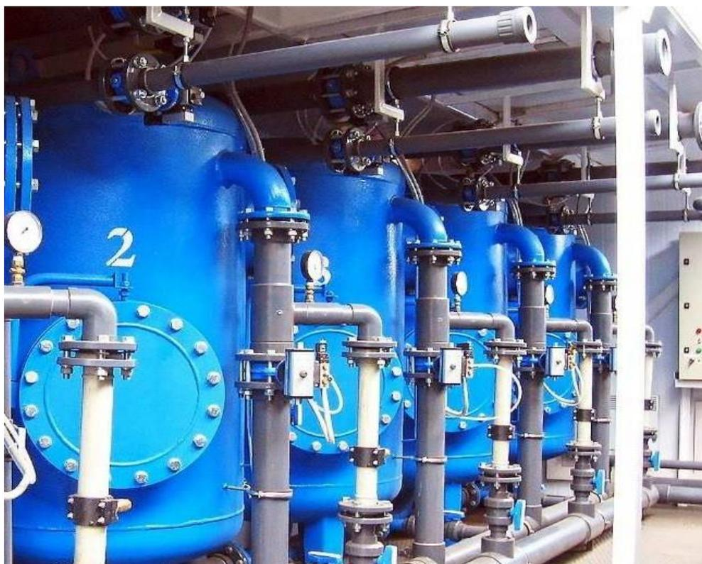
*Рис. 3.5. Скорые напорные фильтры на станции обезжелезивания*
