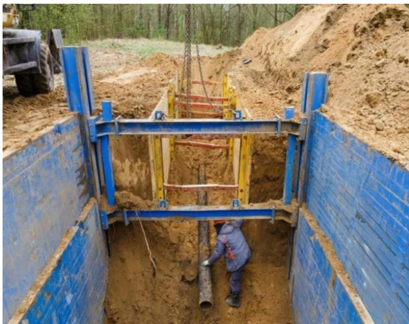
**Рис. 7.6.** Укрепление стенок траншеи при выполнении земляных работ
