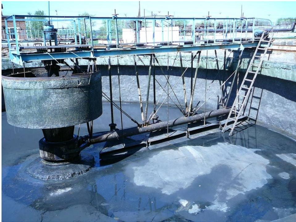
**Рис. 6.5.** Вторичный радиальный отстойник, опорожненный для выполнения работ текущего обслуживания
