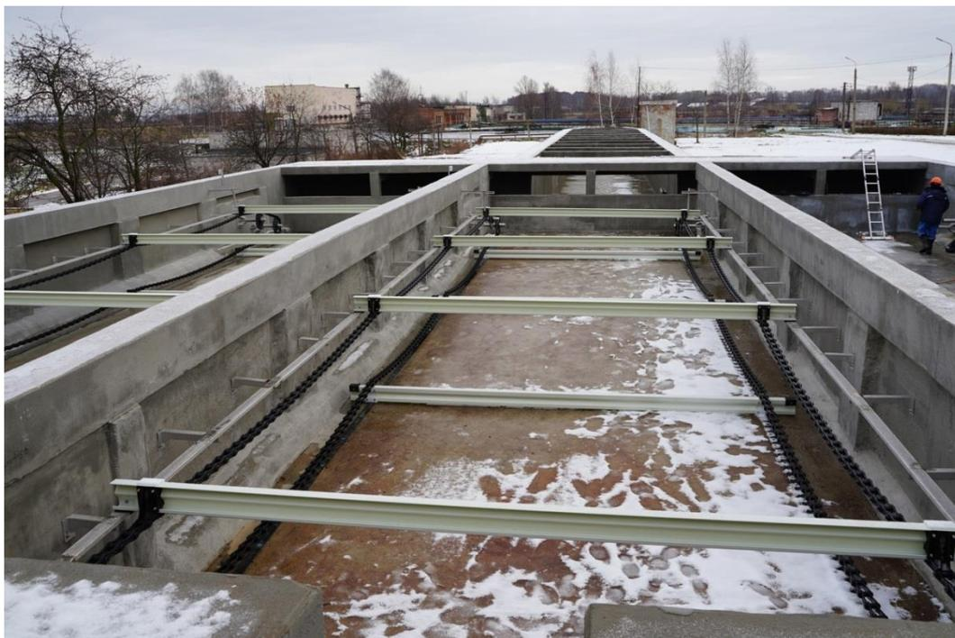
**Рис. 6.2.** Вид опорожненной горизонтальной песколовки со скребковым механизмом
