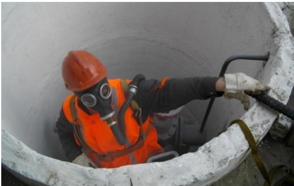
**Рис. 7.5.** Тренировка работы в колодце в колодце шланговом противогазе.
