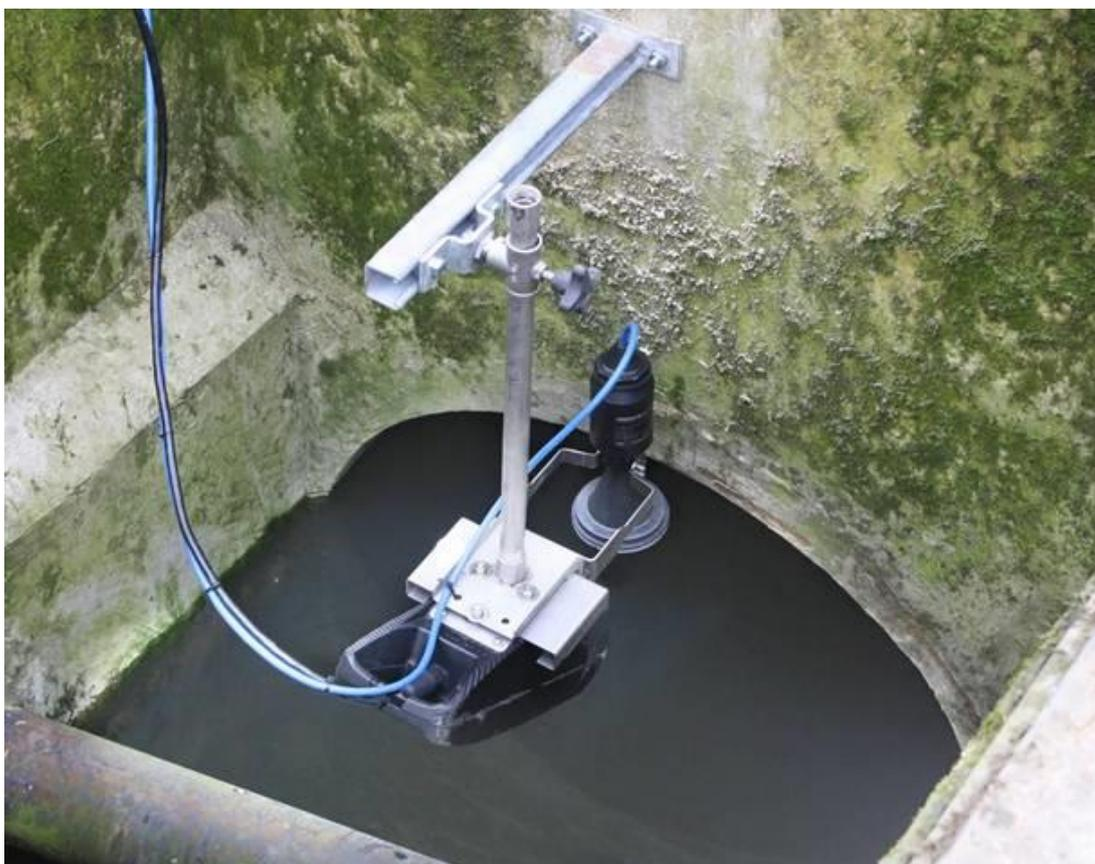
**Рис. 5.3.** Комплекс для измерения расхода воды в безнапорном трубопроводе радарного типа
