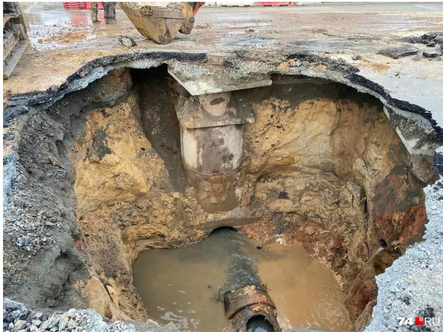
**Рис. 5.7..** Разрушение свода самотечного железобетонного коллектора
