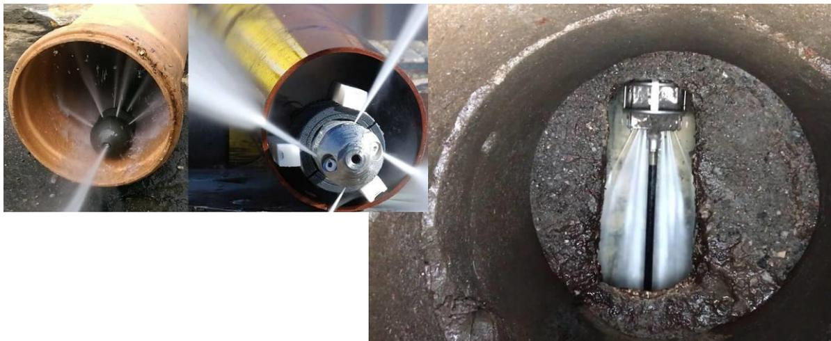
**Рис. 5.2.** *Применение гидродинамической промывки и прочистки заиленных канализационных самотечных трубопроводов*
