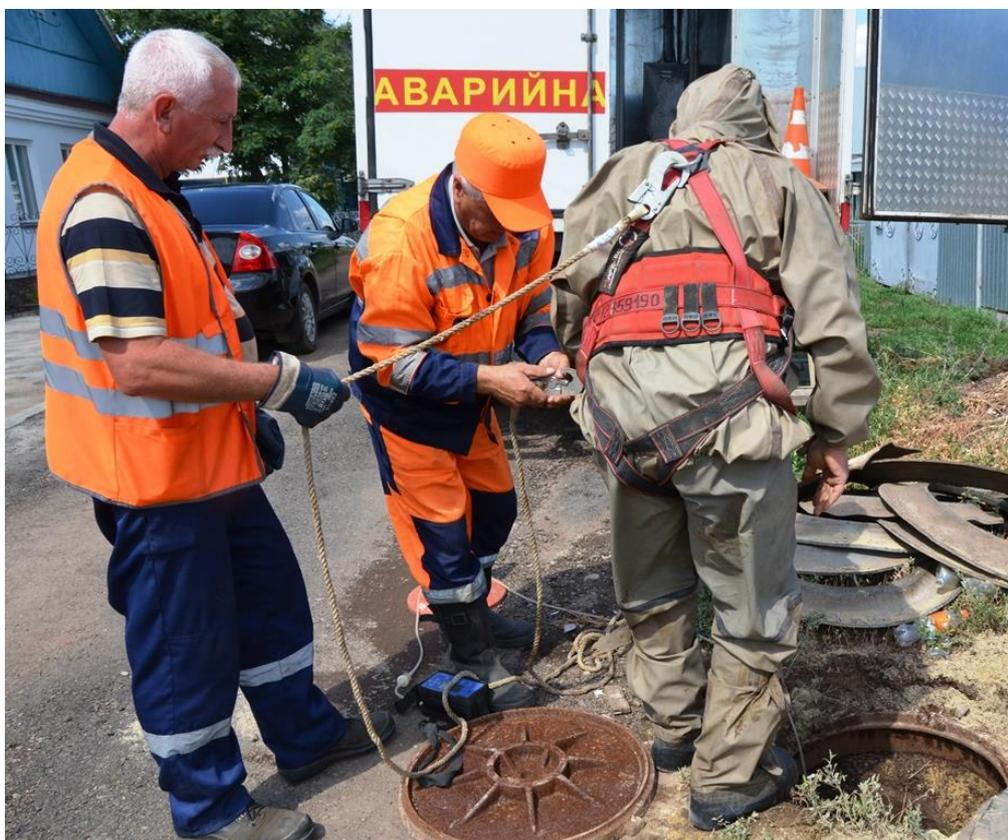
**Рис. 7.3.** Подготовка к спуску в колодец
