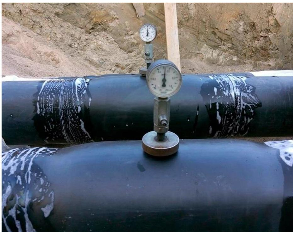
**Рис. 4.2.** Проведение гидравлических испытаний участка магистральных трубопроводов.
