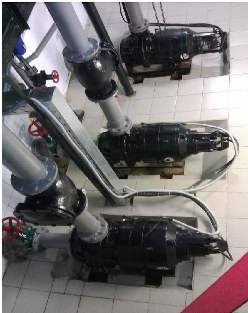
**Рис. 2.3.** *Машинное отделение канализационной насосной станции с насосными агрегатами погружного типа (сухой монтаж)*
