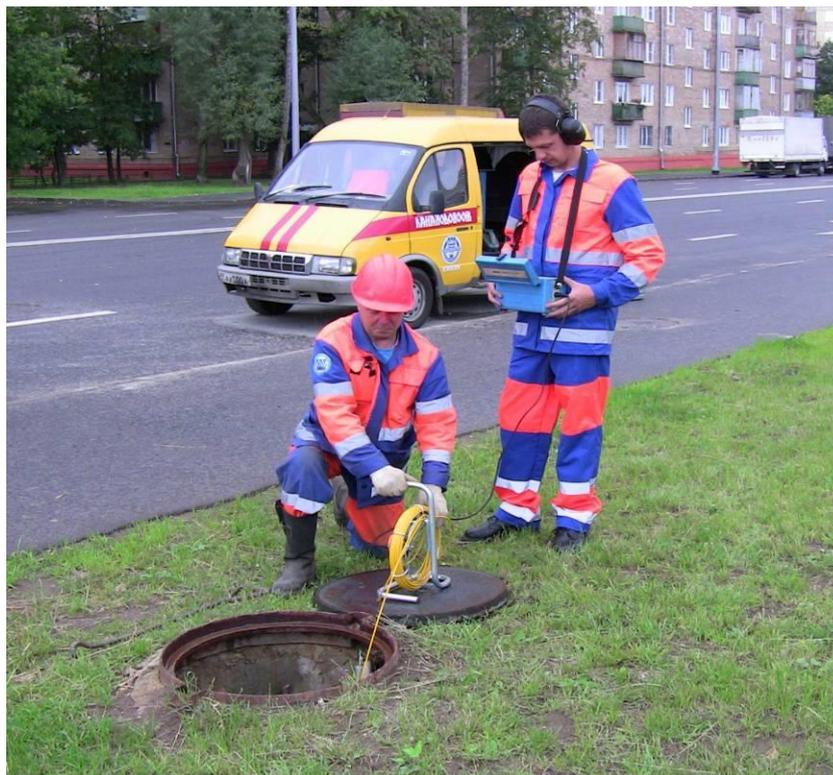
*Рис. 4.3. Поиск утечки с помощью проталкиваемого микрофона*
