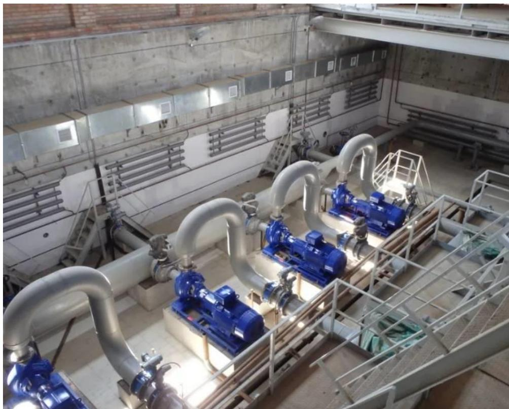
**Рис. 2.1.** *Машинный зал водопроводной насосной станции II-го подъема, полуглубленного типа*
