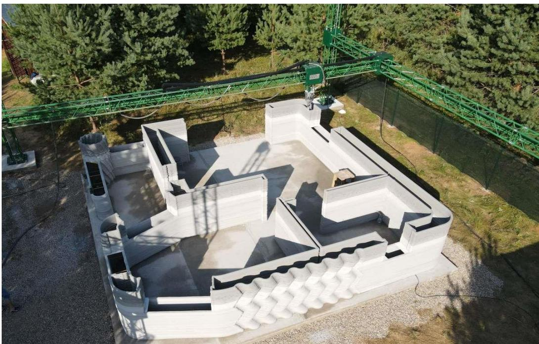
*Рис. 3.7. 3D-принтер «АМТ» для печати на строительной площадке*
