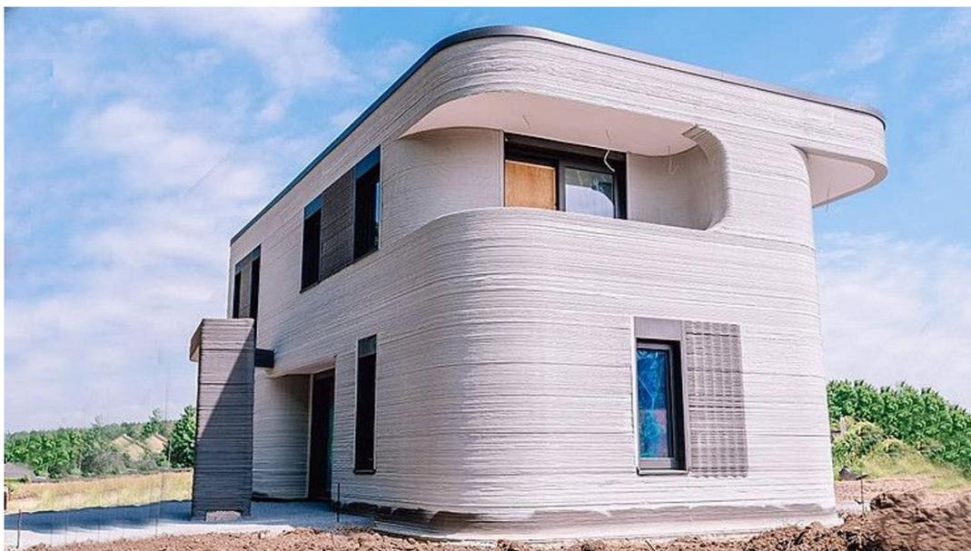
*Рис. 1.13. Напечатанный на 3D-принтере сертифицированный дом, Германия*
