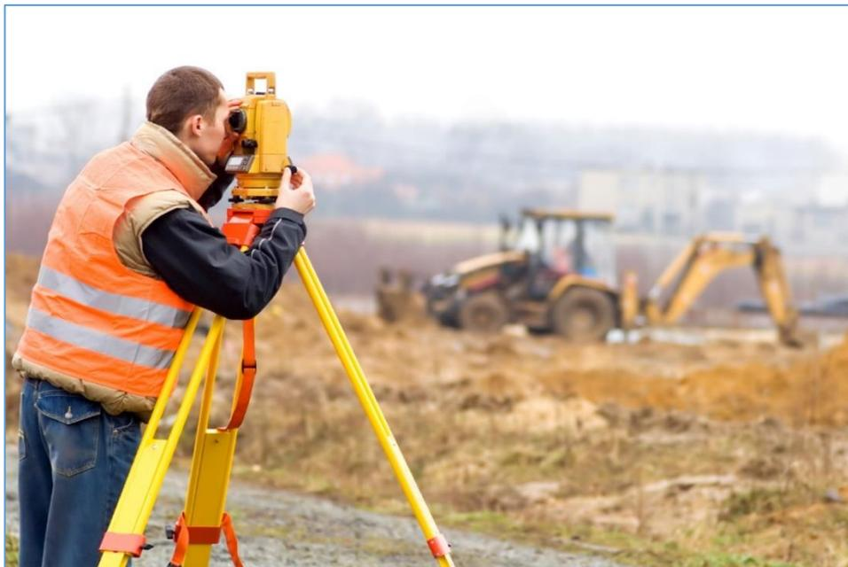
*Рис. 4.1. Процесс геодезической разбивки территории*
