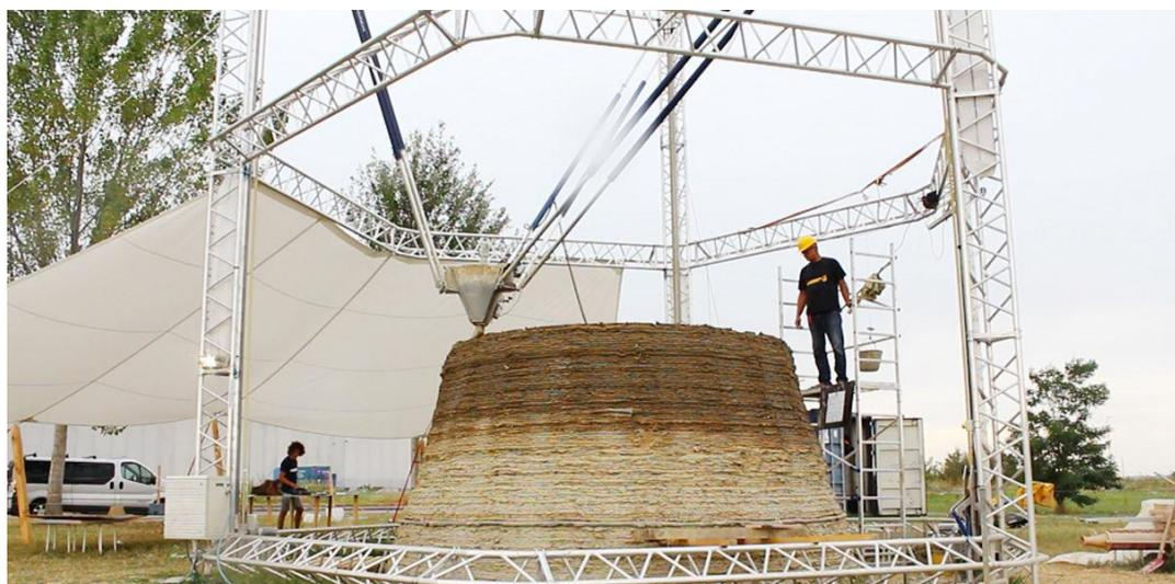
*Рис. 3.2. Строительный 3D-принтер типа «дельта»*
