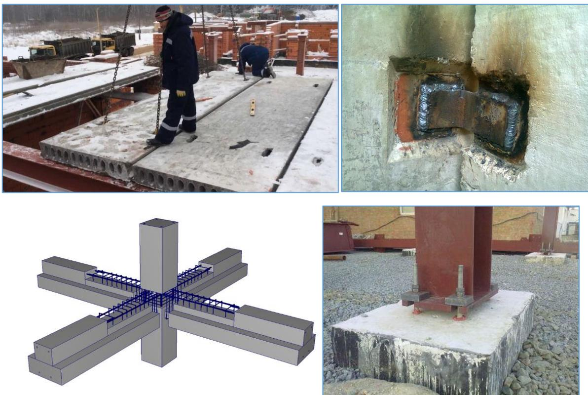
*Рис. 5.11. Стыки между сборными элементами*
