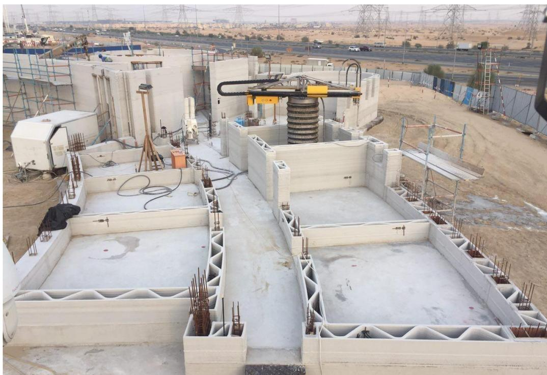
*Рис. 1.14. Строительство зданий с применением 3D-печати в г. Дубай*
