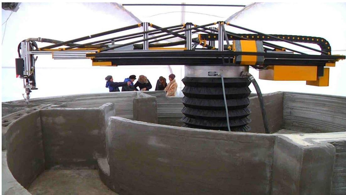
*Рис. 3.14. Процесс 3D-печати здания*
