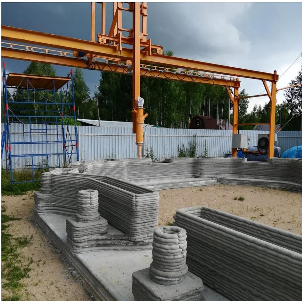
*Рис. 4.8. 3D-печать несъемной опалубки контура стен здания*
