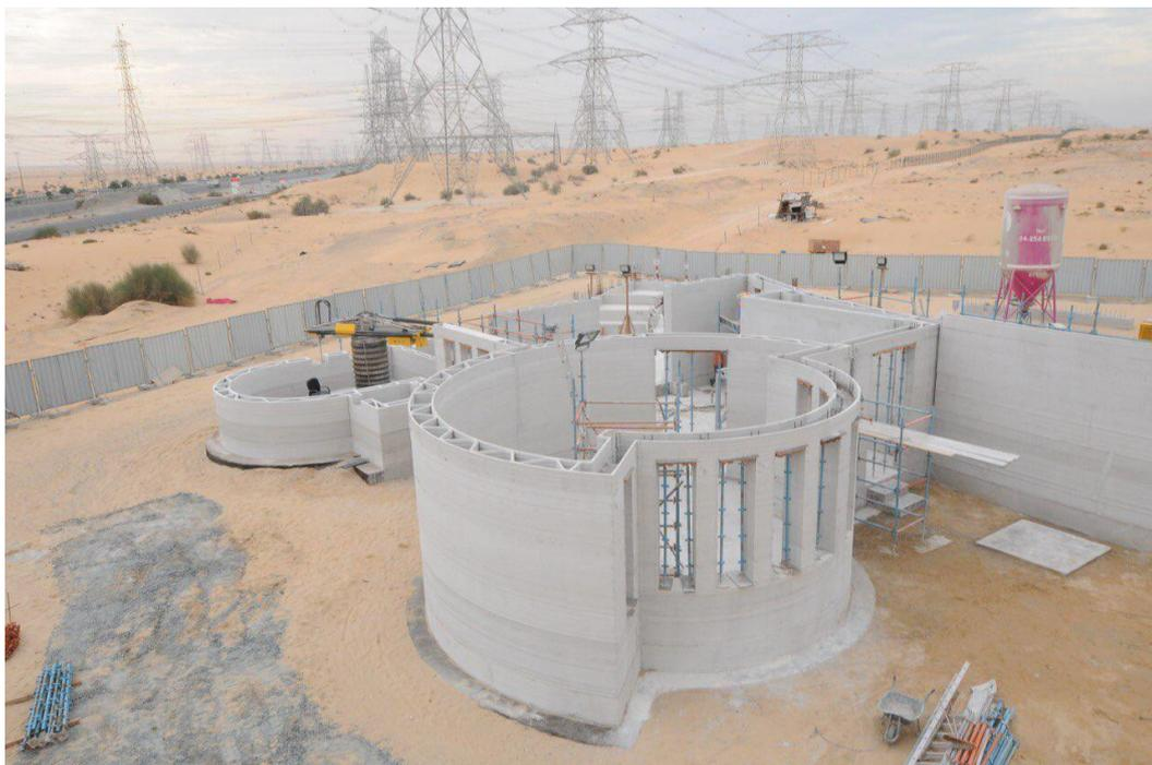
*Рис. 3.15. Процесс 3D-печати на строительной площадке*
