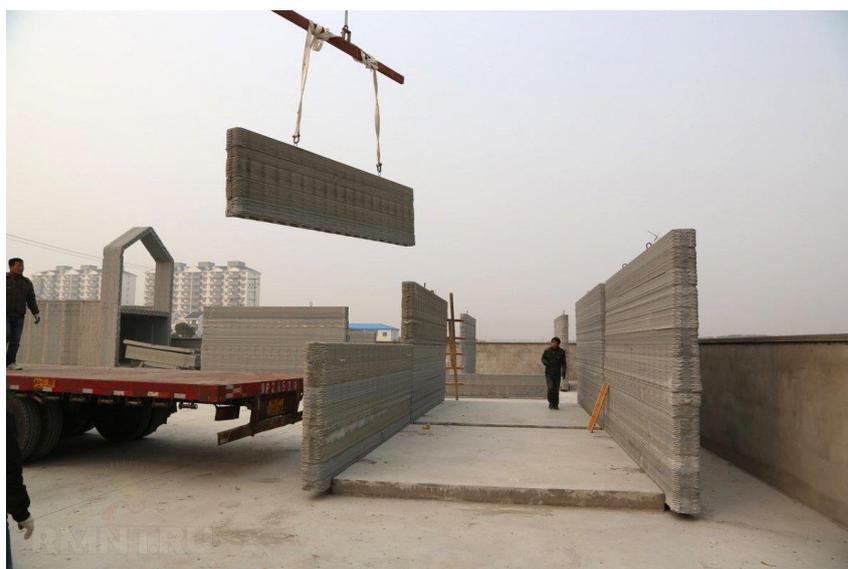
Рис. 5.2. Разгрузка сборных элементов, изготовленных 3D-принтером компании WinSun
