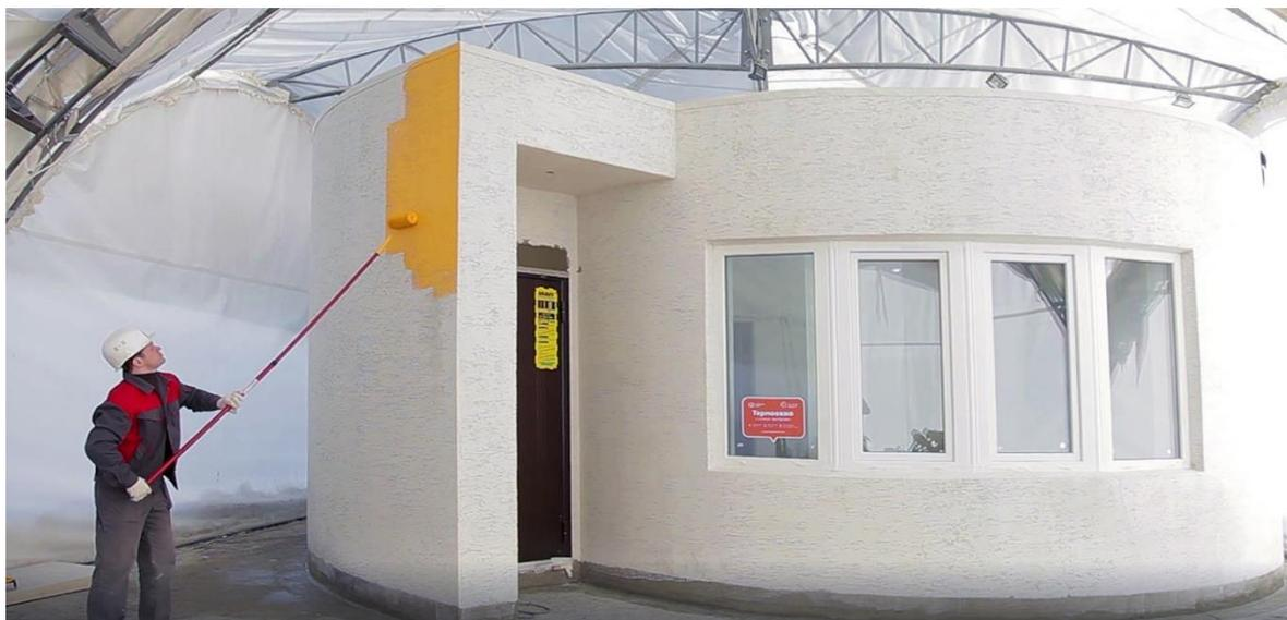
*Рис. 4.10. Процесс наружной отделки здания, построенного с применением 3D-печати*
