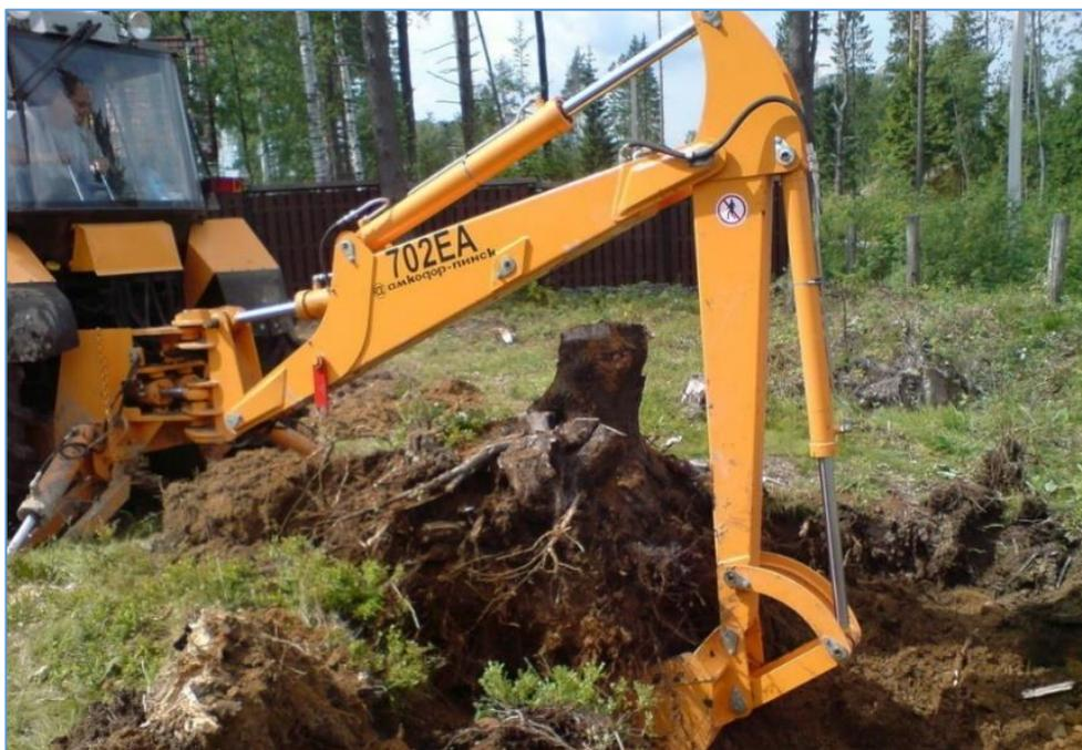
*Рис. 4.2. Процесс удаления деревьев и кустарников, попадающих в зону застройки*
