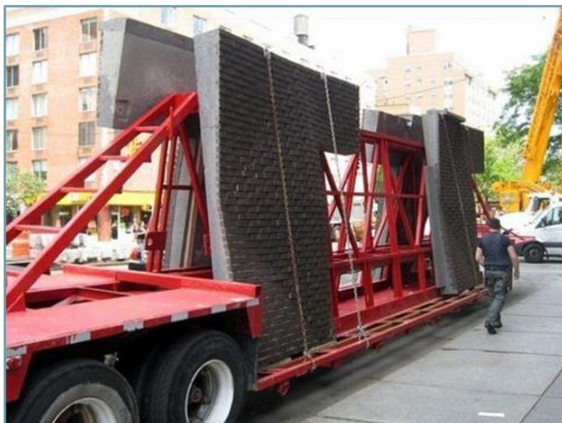
Рис. 5.1. Доставка сборных элементов спецавтотранспортом
