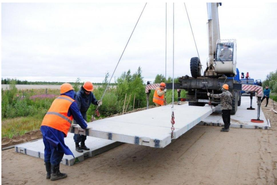
*Рис. 4.4. Устройство временных дорог из дорожных плит*
