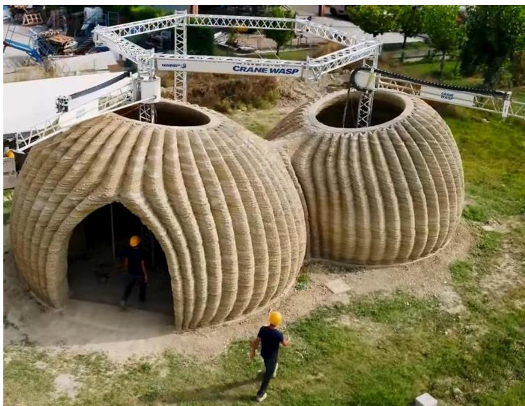
*Рис. 3.5. Экологически устойчивый дом TECLA, напечатанный на 3D-принтере, Италия*
