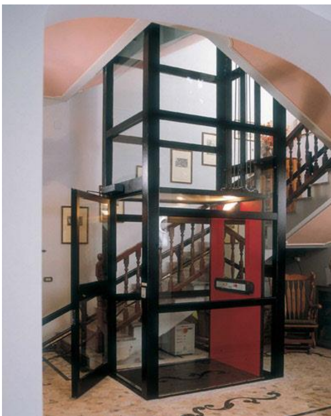
Рис. 4.18. Общий вид платформы подъемной для инвалидов, установленной в шахте
