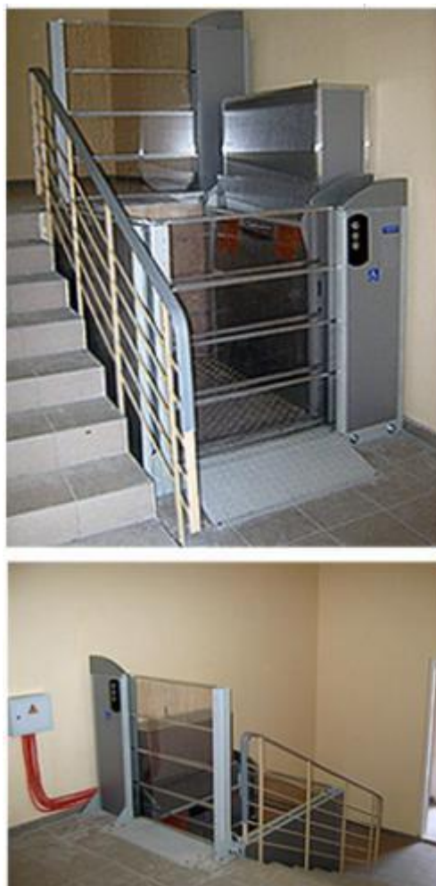
Рис. 4.19. Общий вид платформы подъемной для инвалидов вертикального перемещения без шахты
