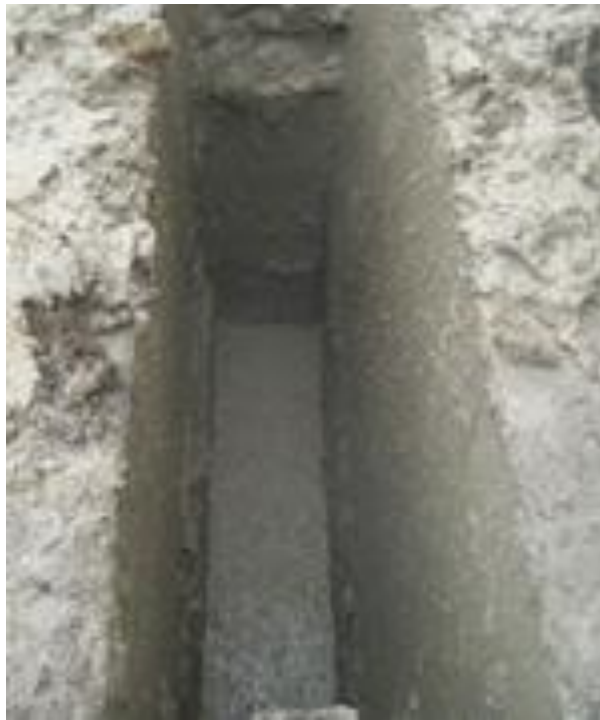
Рис. 8.9. Разработка грунта
