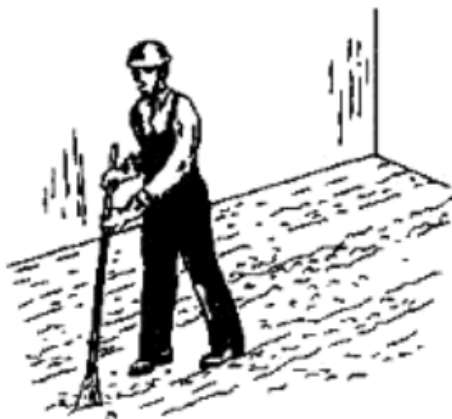
Рис.11. Очистка поверхности плиты от грязи
