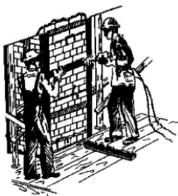
Рис.9. Прихватка сваркой планок металлического каркаса
