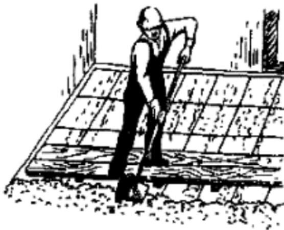
Рис.12. Надбетонирование плиты монолитного перекрытия
