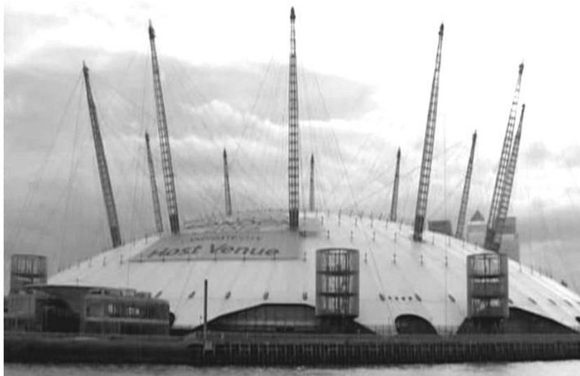
*Рис.3.15. Стадион с подвесным покрытием*
