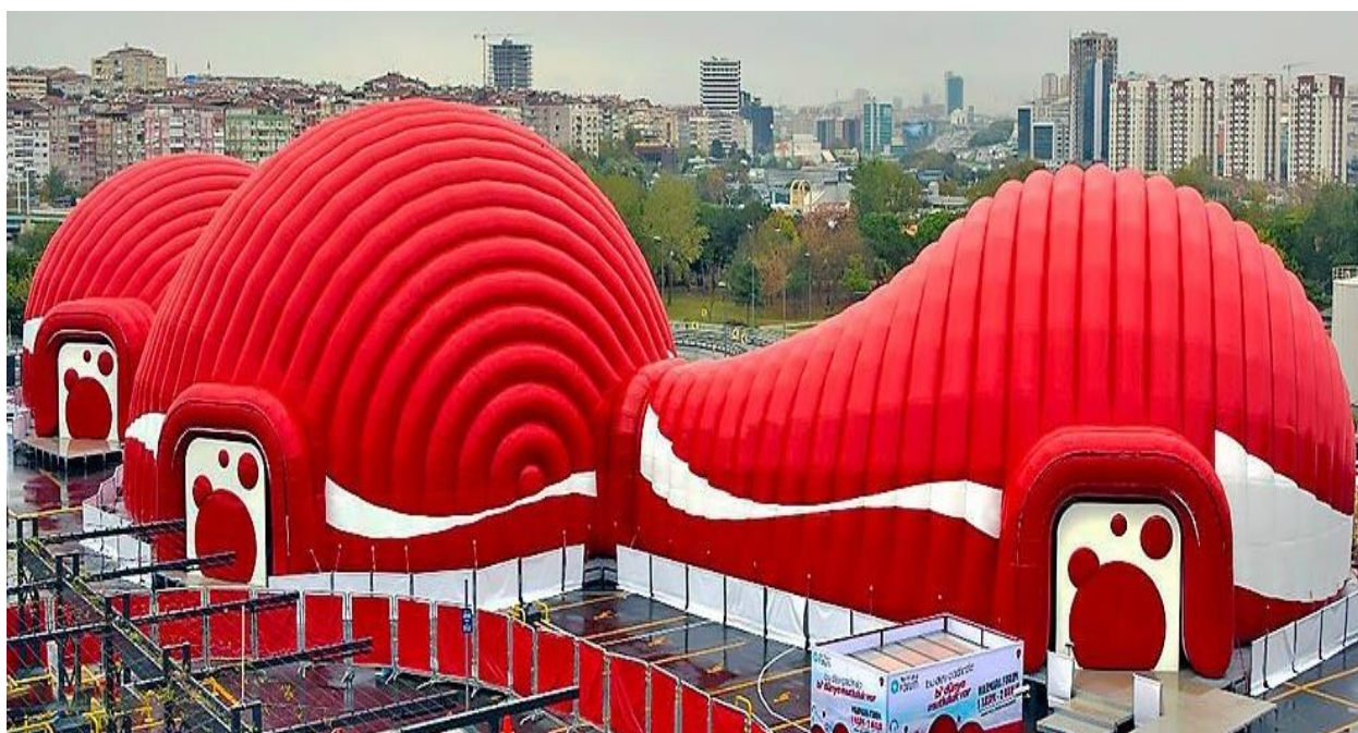
Рис. 1. Пневматическая конструкция. Общий вид.
