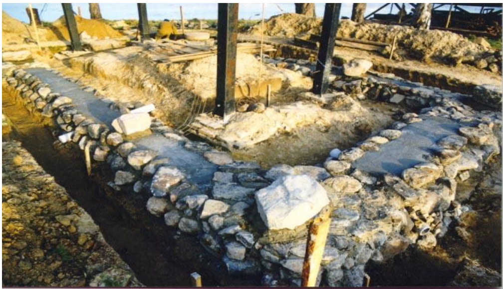
Рис.16. Усиление деревянных столбчатых фундаментов: увеличение площади фундаментов
