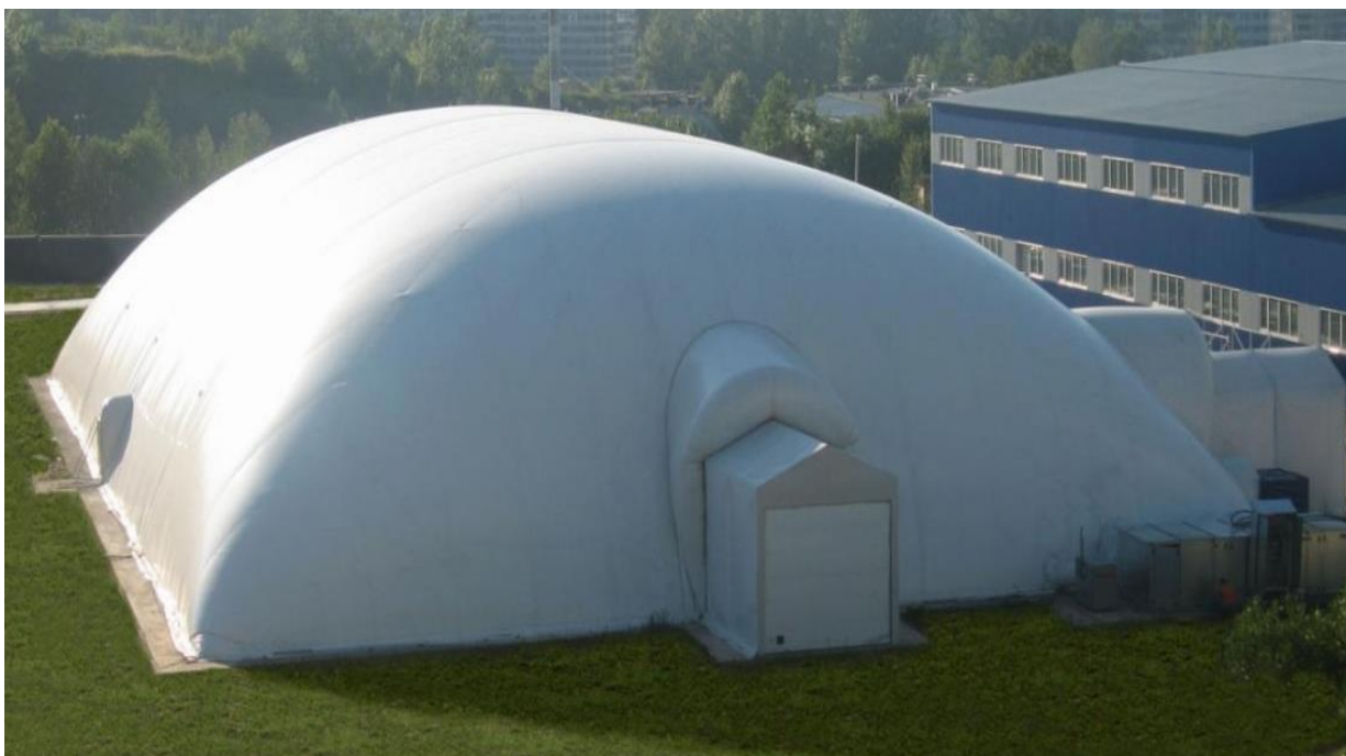
Рис. 2. Воздухоопорная конструкция
