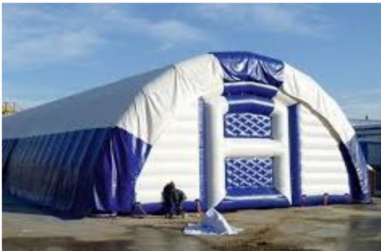
Рис. 3. Пневмокаркасная конструкция
