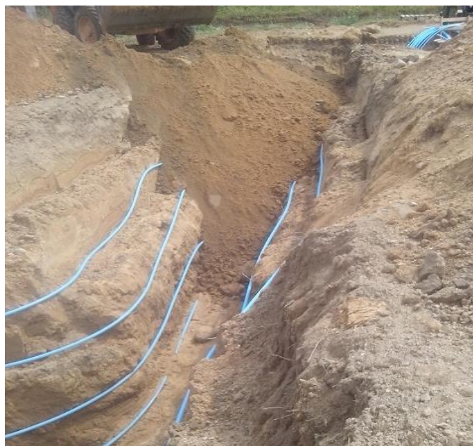
Рис. 8 Траншея горизонтального грунтового теплообменника «многоэтажка» перед засыпкой
