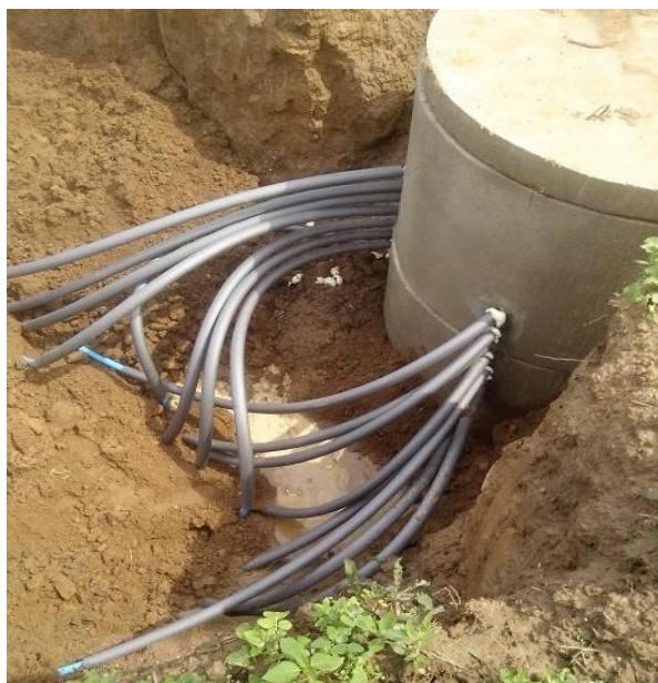
Рис. 11 Ввод труб в колодец.
