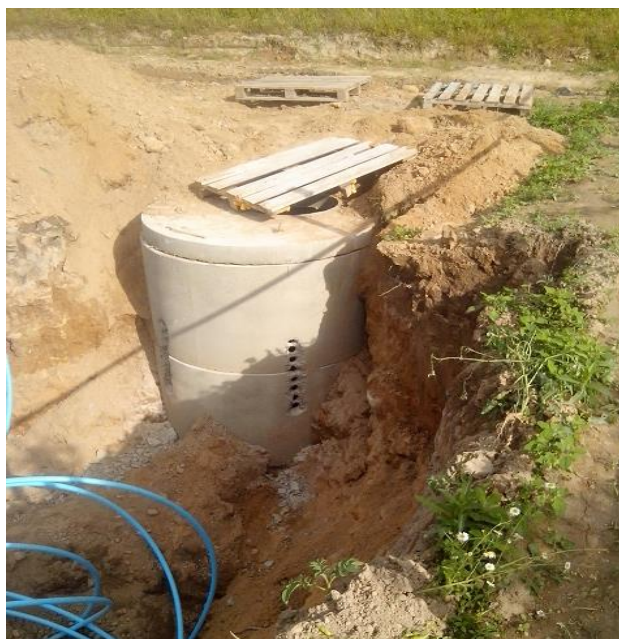
Рис. 10 Установка колодца.
