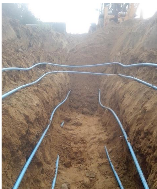
Рис. 9. Засыпка конца траншеи
