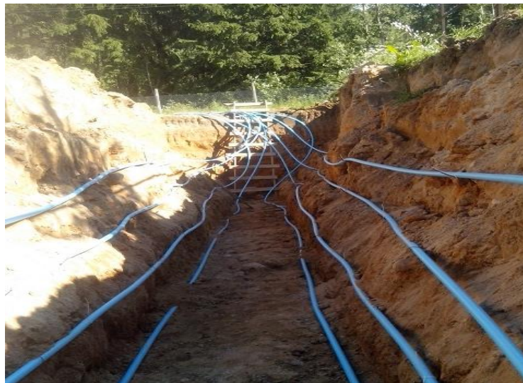
Рис. 7. Трениея горизонтального грунтового теплообменника «многоэтажка» с трубами
