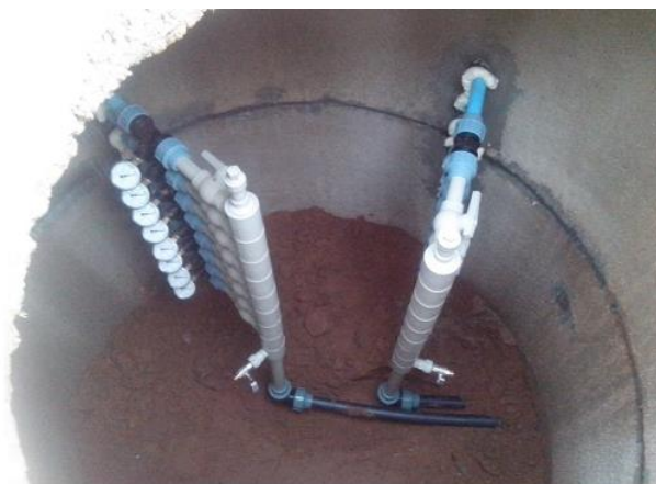
Рис. 14. Монтаж сборного коллектора в колодце
