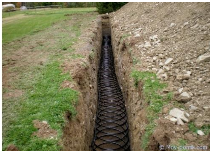
Рис. 4 Горизонтальный грунтовый коллектор «slinky»
