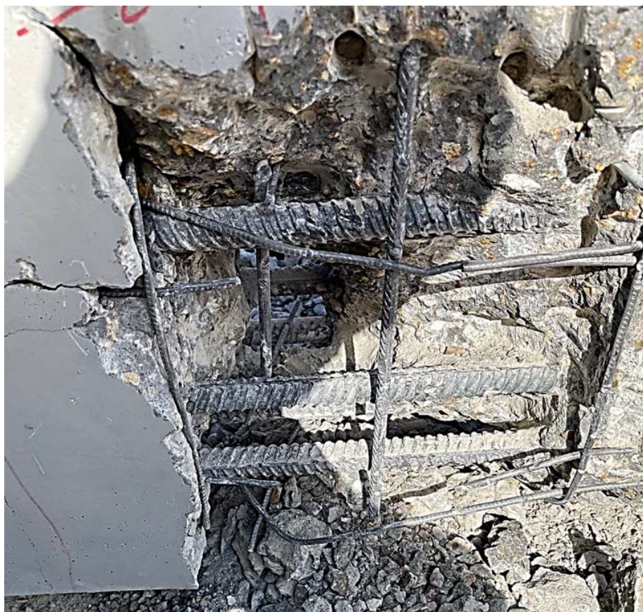
Рисунок 7.2. Вскрытие арматурных стержней нижнего пояса балки
