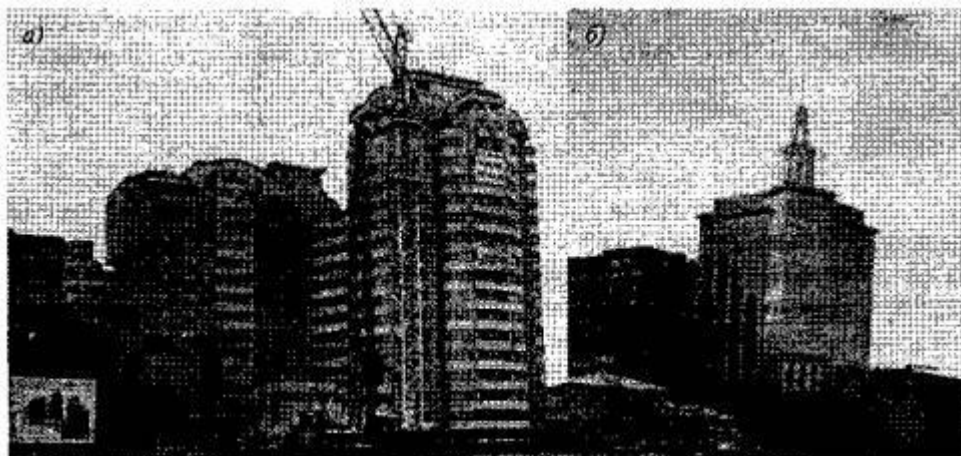
Рис. 4.2.15. Общий вид жилого комплекса первой очереди строительства (а) и каркасно-панельного здания с перепрофилированием в банковско-офисное (б)
