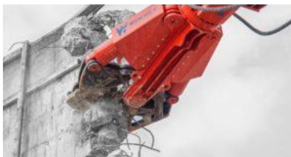
Рис. 4.1.10. Грейферы – инструмент для демонтажа стен
