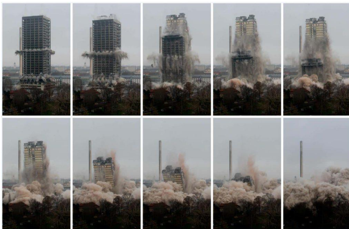
Рис. 4.1.4. Взрывной способ демонтажа здания
