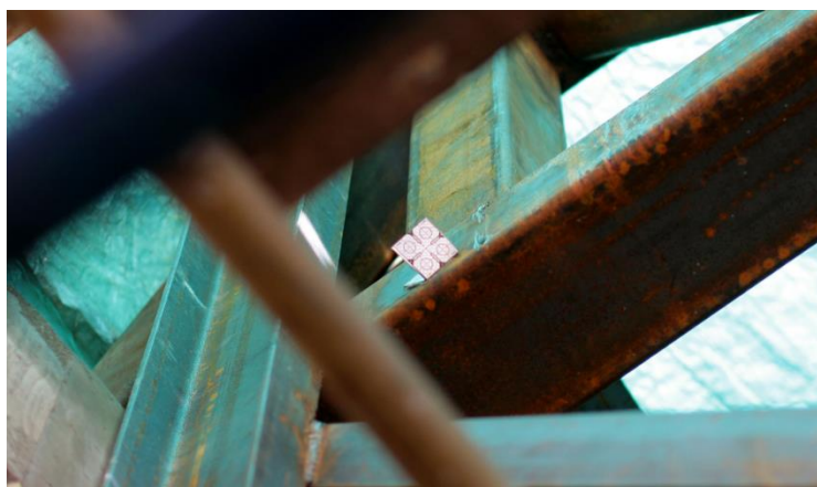
Рисунок 5.4. Пластиковый катафотный отражатель, закрепленный на металлических конструкциях
