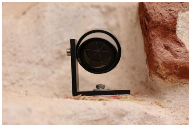
Рисунок 5.5. Световозвращающая призма на несущих конструкциях здания
