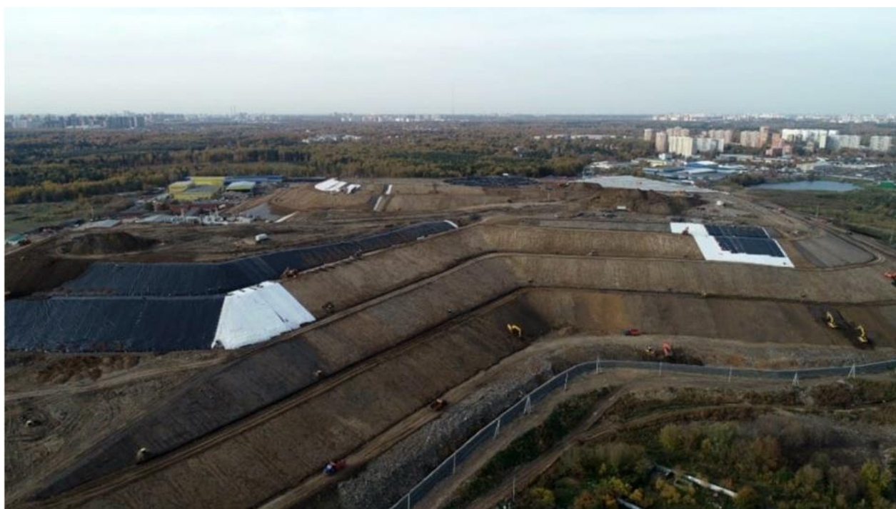
Рис. 2.17. Фото полигона ТКО
