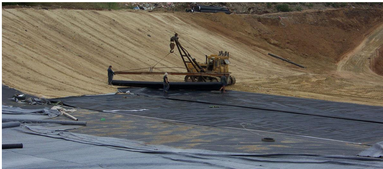
Рис. 2.18. Фото работ по устройству полигонов ТКО
