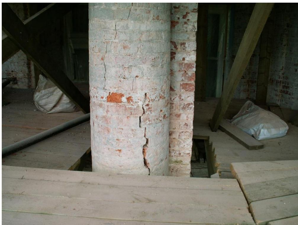
*Рис. 8.18. Общий вид столбов из кирпичной кладки с повреждениями трещинами*
