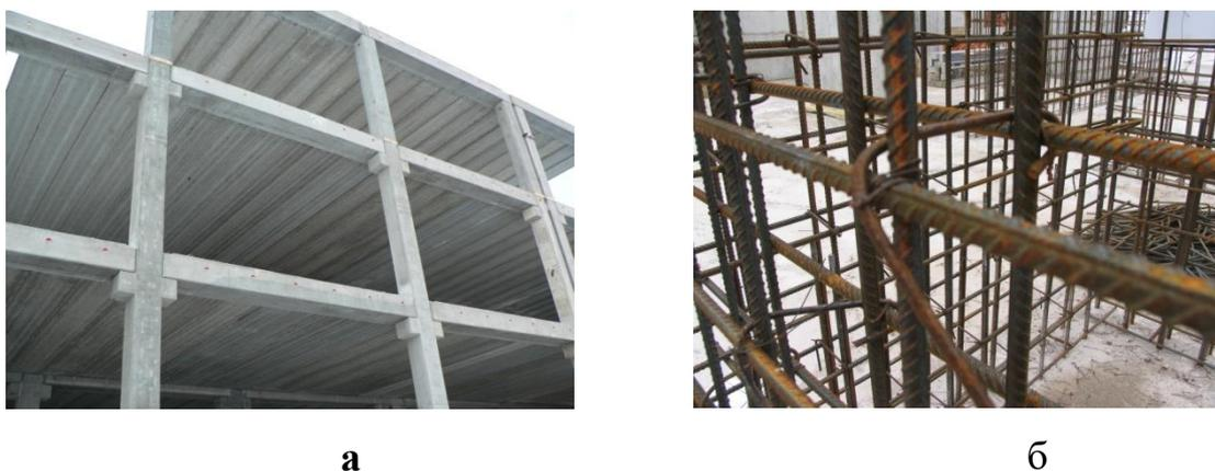
Рис. 1.27. Строительство сборного (а) и монолитного (б) здания
