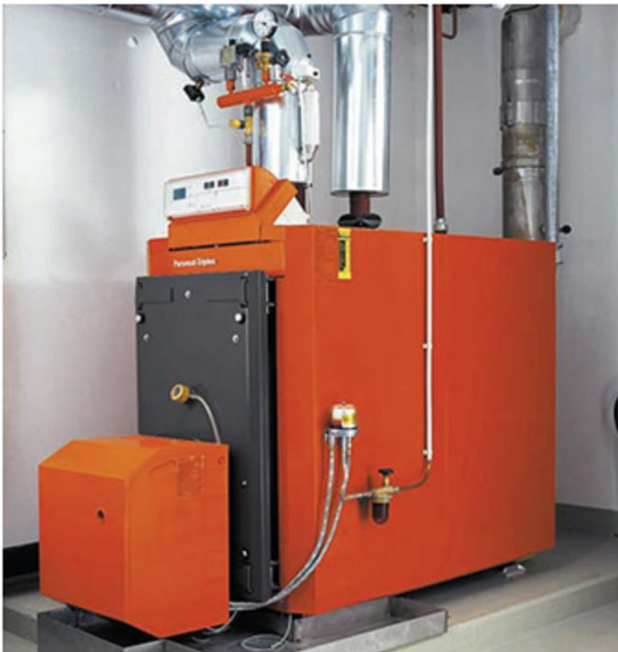
Рис. 6.2. Стальной газотрубный котел
