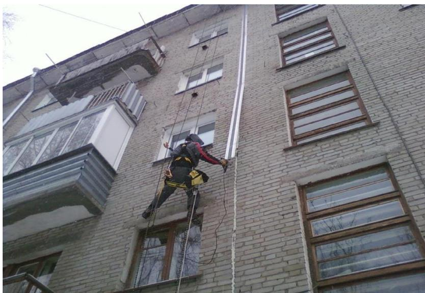
*Рис. 1. Ремонт деформационных швов*
