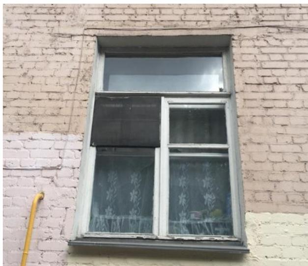
*Рис. 10. Оконные блоки деревянные*
