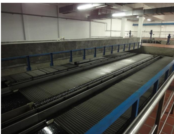
Рис. 1.18. Отстойник с тонкослойными модулями
