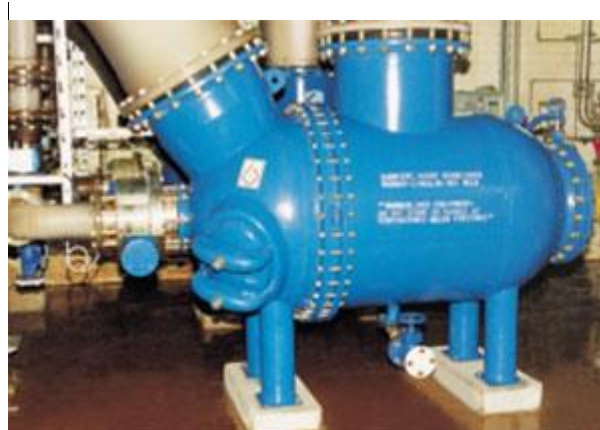
Рис. 2.31. Сетчатый фильтр PR-BW 100-FC с автоматической промывкой:
