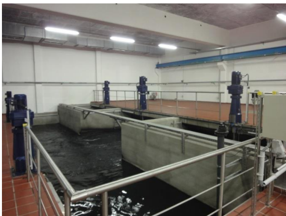
Рис. 1.17. Механические смесители и камера хлопьеобразования
