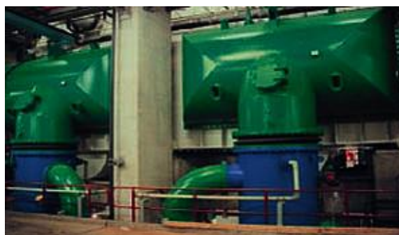
Рис. 2.32. Сетчатый фильтр PR-BW 400 с автоматической промывкой:
