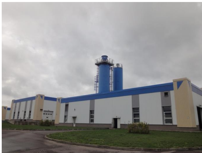
Рис. 1.20. Здание реагентного хозяйства (цех гипохлорита натрия, аммиачной воды и активированного угля)
