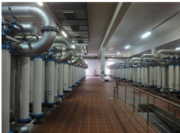
Рис. 1.21. Зал мембранных фильтров
