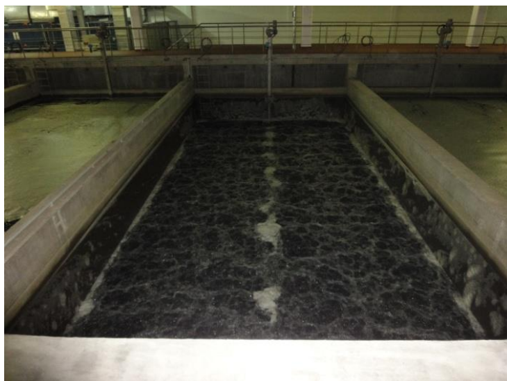
Рис. 1.19. Скорый фильтр, водовоздушная промывка
