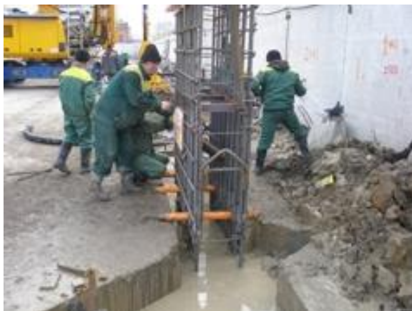
Рис. 8.10. Установка арматуры
