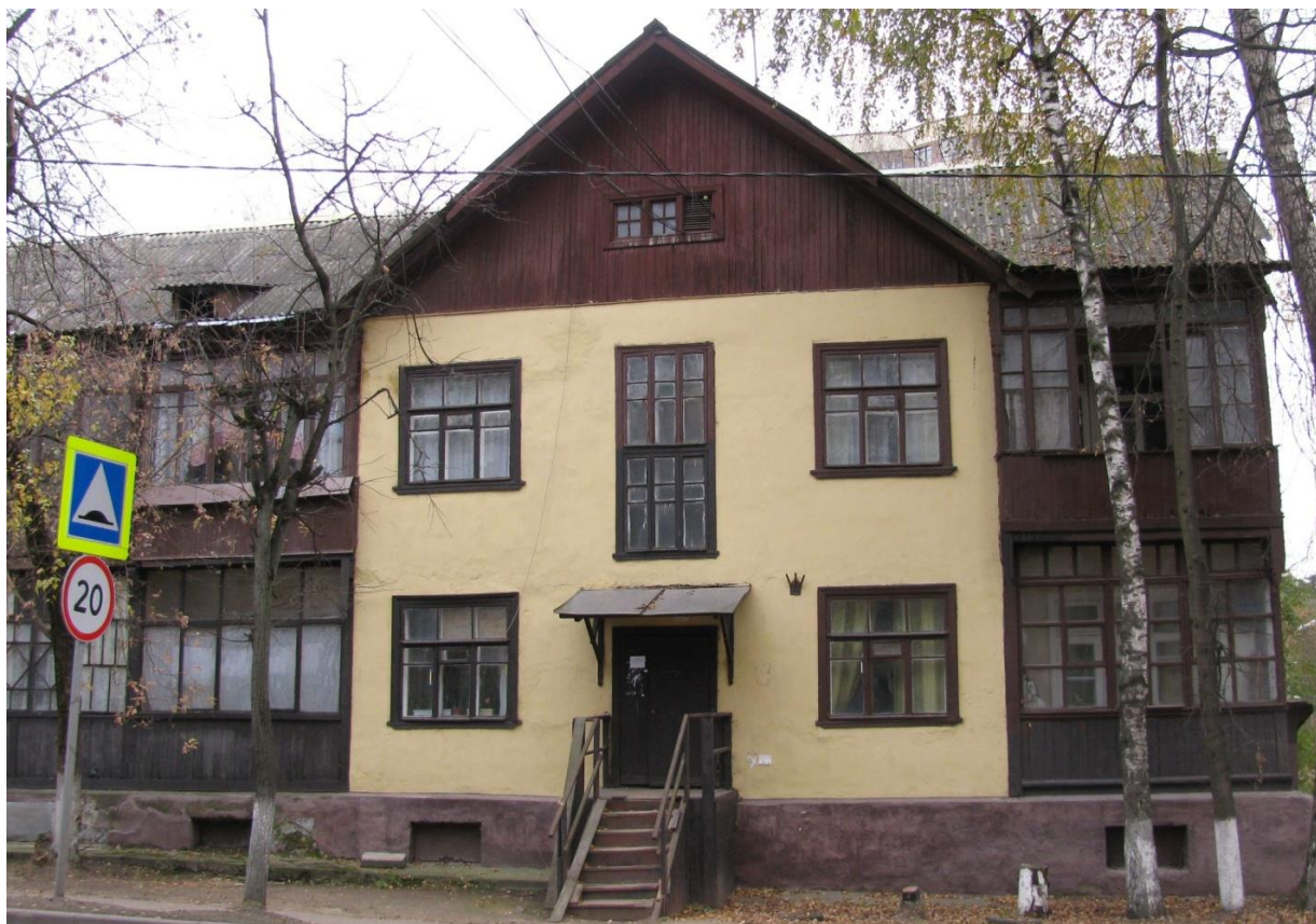
Рис. 3.1 Передний фасад в осях 6-12.
