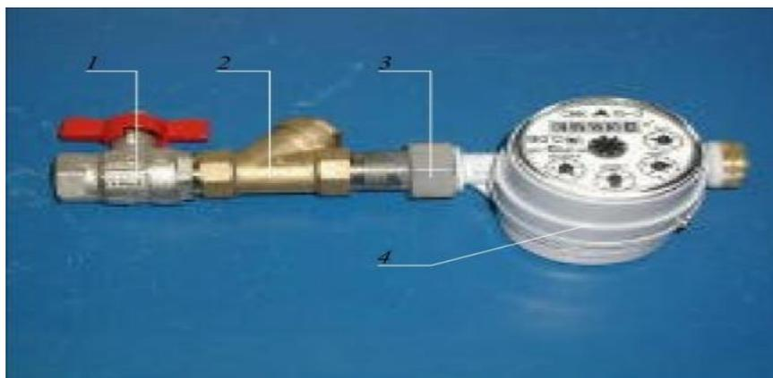
Рис.43. Водомерный узел квартирный.
