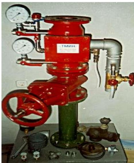
Рис.69 Общий вид контрольно-сигнального клапана (КСК) с запорной арматурой
