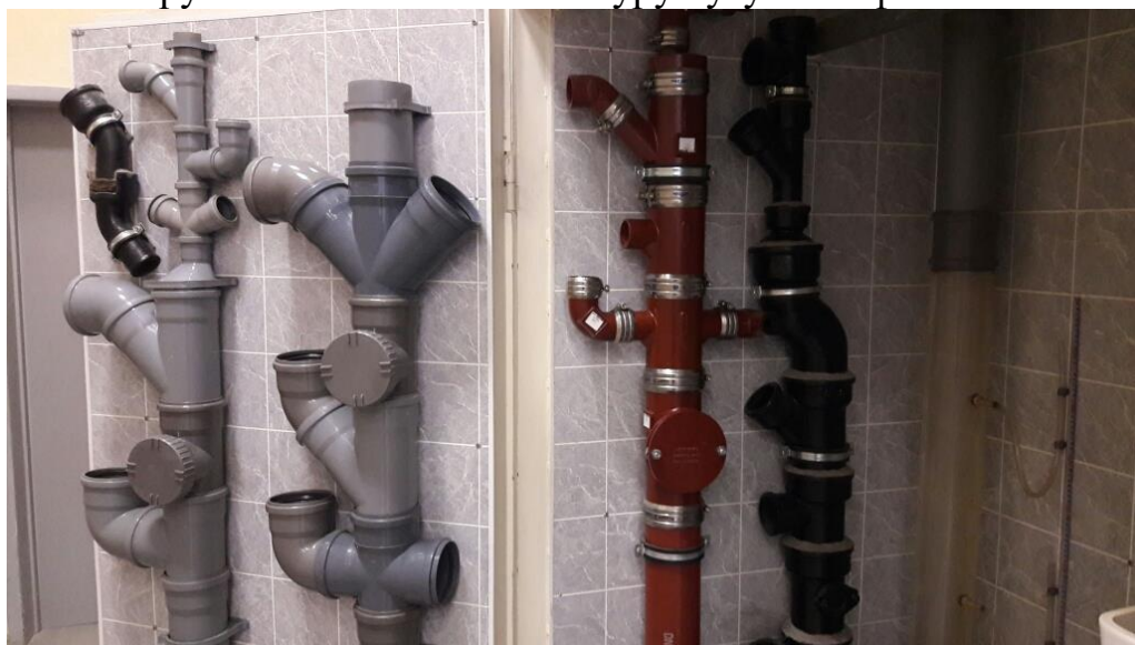
Рис. 4.2. Общий вид лабораторного стенда. Соединение пластмассовых и чугунных труб канализации
