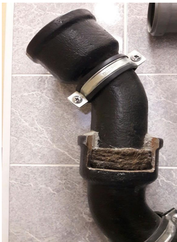
Рис. 4.1. Соединение чугунных труб канализации
