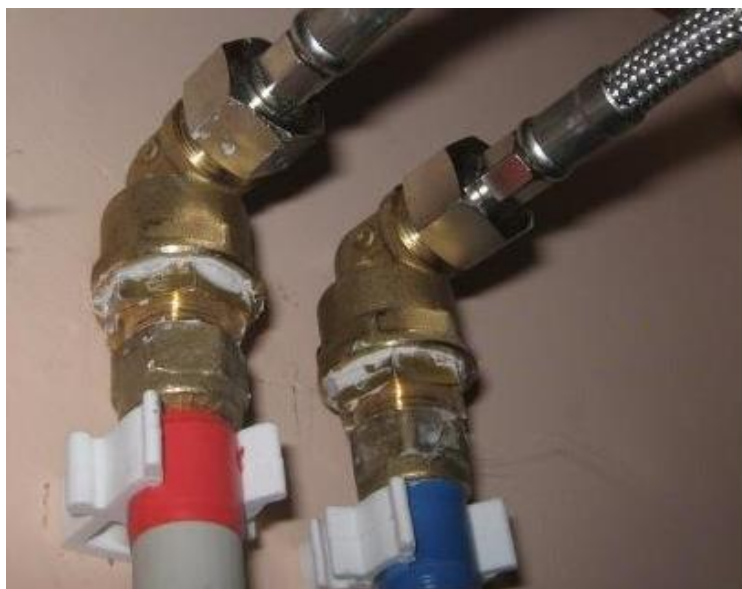
Рис. 1.5. Резьбовое соединение с накладной гайкой
