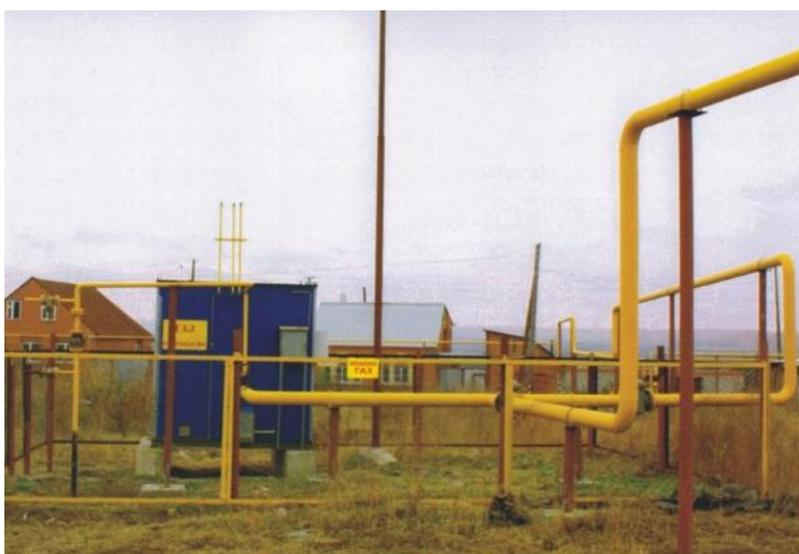
*Рис. 5.3. Стальные наружные поселковые газопроводы низкого давления*
