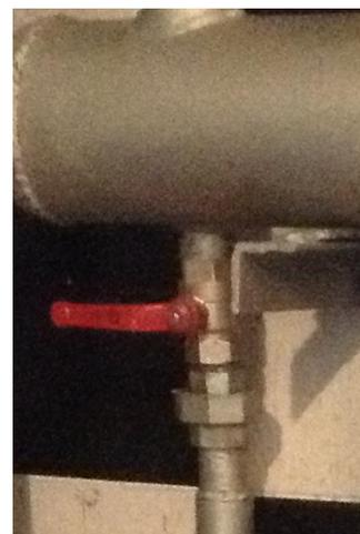
*Рис. 2.31. Примеры резьбовых соединений*
