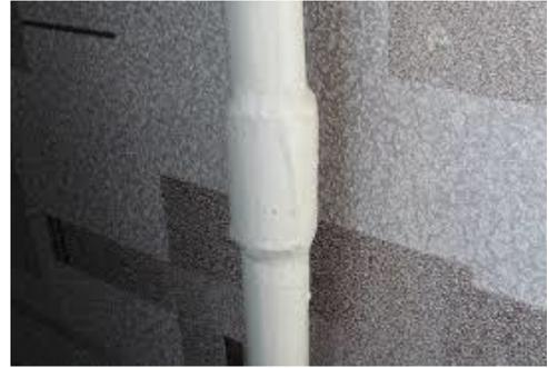
Рис. 2.29. Соединение внахлестку
