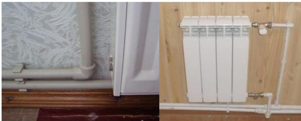
*Рис. 2.3. Внешний вид полипропиленовых трубы системы отопления*
