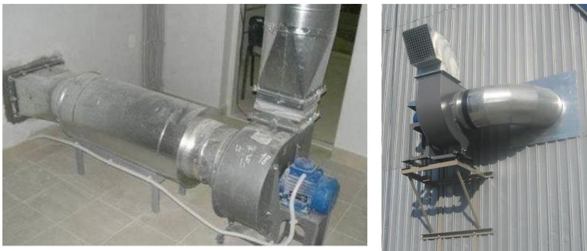
Рис. 3.15. Примеры установки радиальных вентиляторов в качестве вытяжной установки
