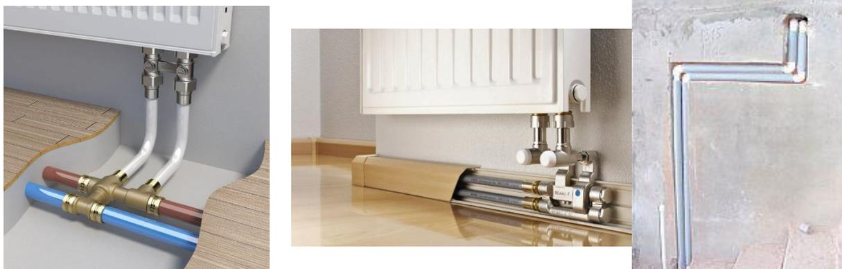
Рис. 2.33. Скрытая прокладка полимерных труб водяного отопления
