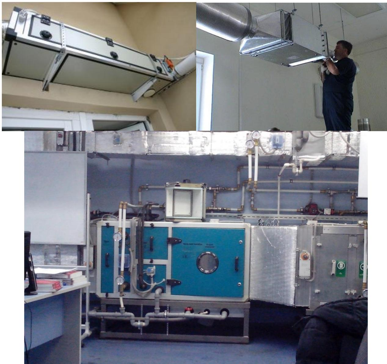
*Рис. 3.48. Примеры установки приточных установок*
