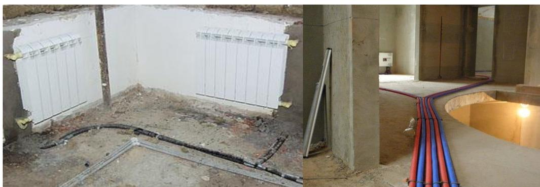
*Рис.2.4. Внешний вид трубы системы отопления из сшитого полиэтилена*
