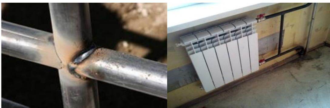
*Рис. 2.1. Внешний вид стальных трубы системы отопления*
