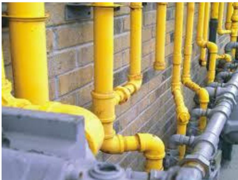
Рис.5.4. Полиэтиленовые наружные вводные газопроводы низкого давления
