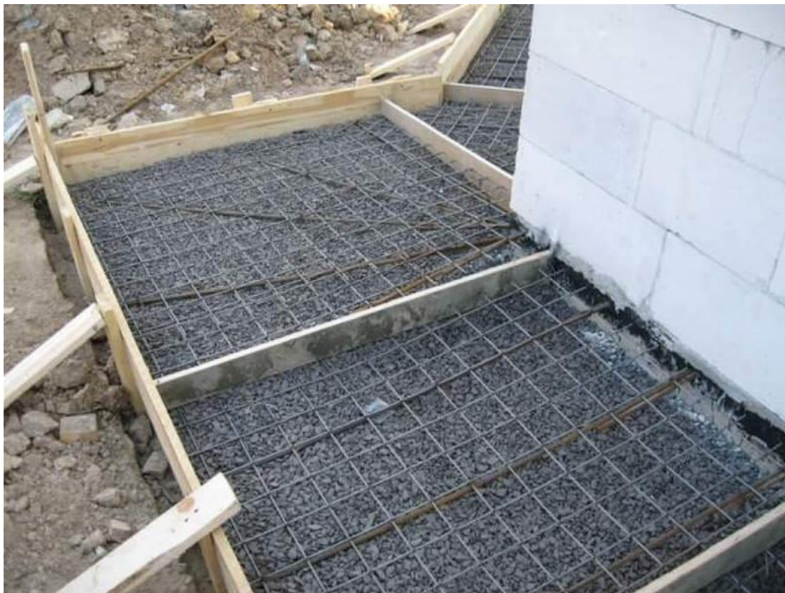
Рисунок 3.2 – Пример скрытой работы при капитальном ремонте, устройство основания отмостки из щебня.
