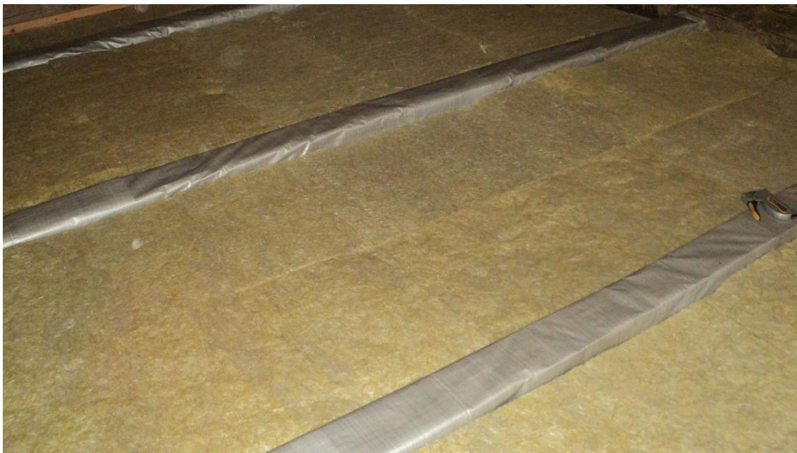
Рисунок 3.3 – Пример скрытой работы при капитальном ремонте, утепление чердачного перекрытия.
