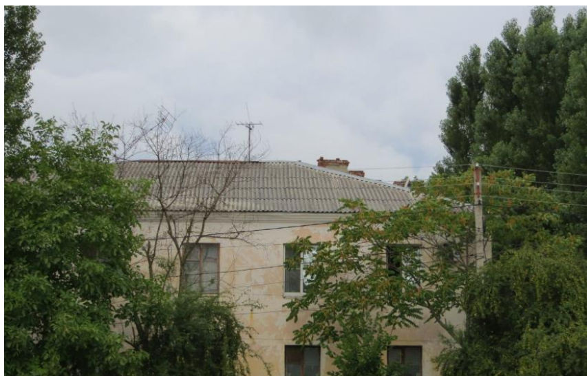
Рис. 3. До выполнения ремонтных работ
