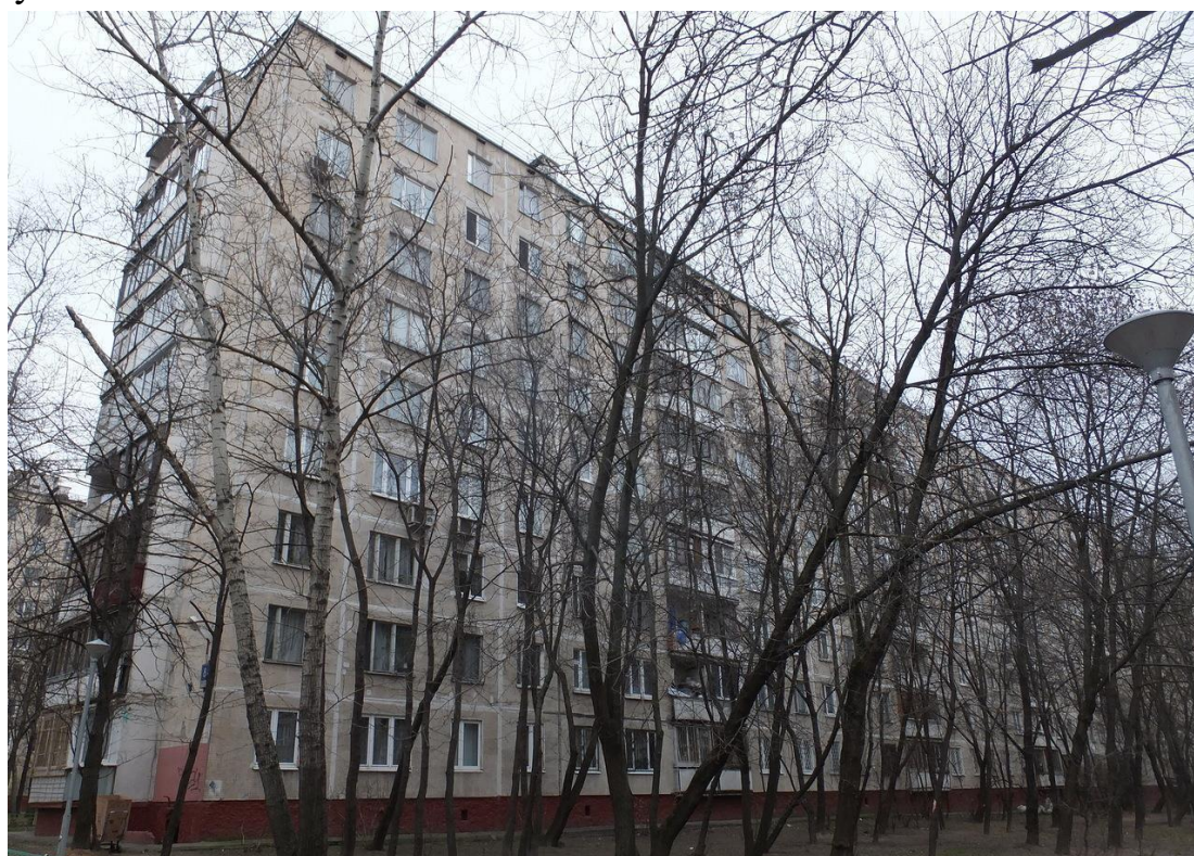
Рис.1. Фасад здания, расположенного по адресу г. Москва, Ярославское шоссе, д. 8, к. 1
