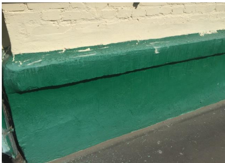
Рис. 12. Покраска цоколя (окраска масляная)
