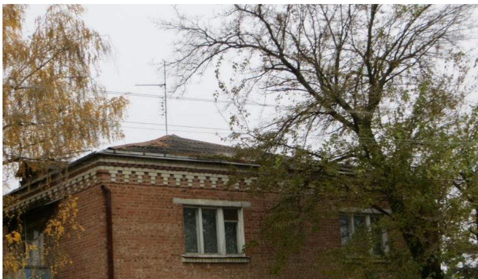
Рис. 5. До выполнения ремонтных работ
