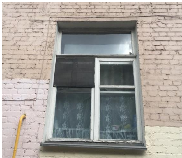
Рис. 10. Оконные блоки деревянные
