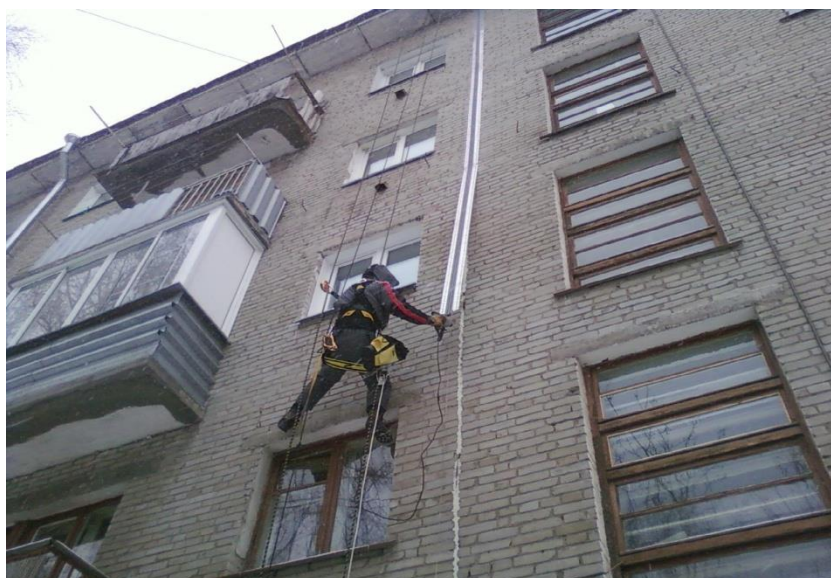
Рис. 1. Ремонт деформационных швов
