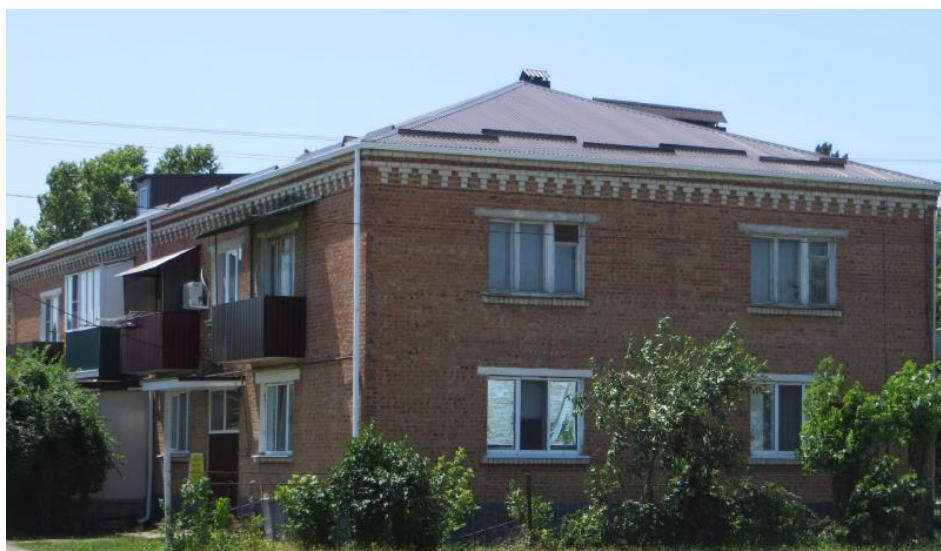
Рис. 6. После выполнения ремонтных работ
