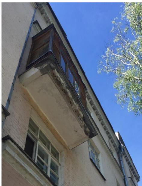
Рис.8. Балконы из ж/б плиты, козырёк из ж/б плиты над входной группой (балконы, козырьки)
