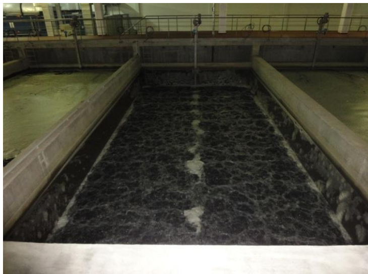
Рис. 1.7. Скорый фильтр, водовоздушная промывка
