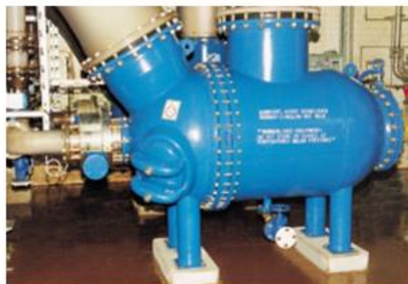
Рис. 2.21. Сетчатый фильтр PR-BW 100-FC с автоматической промывкой:
