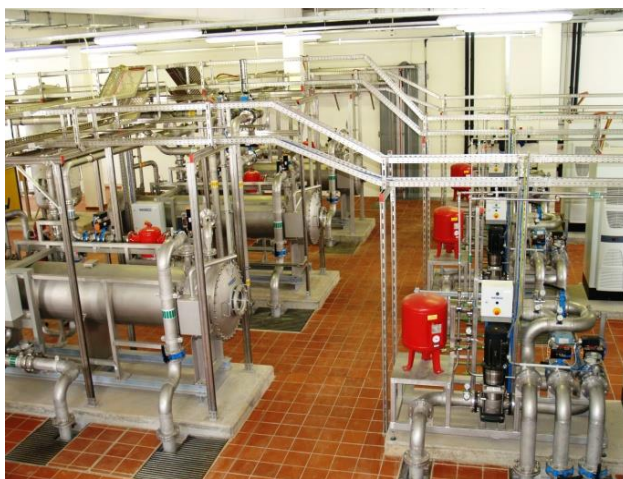
Рис. 1.10. Озонаторная установка
