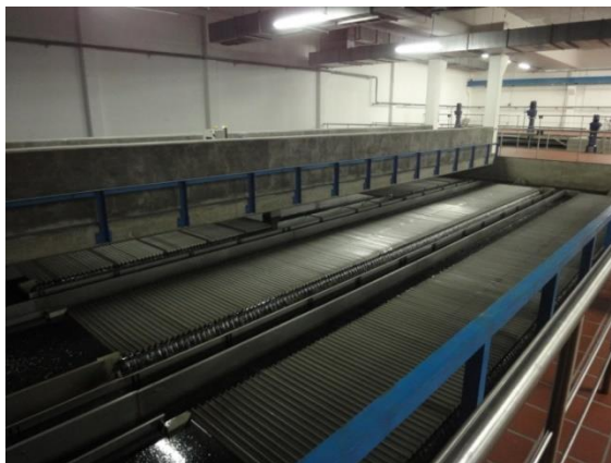
Рис. 1.5. Механические смесители и камера хлопьеобразования
