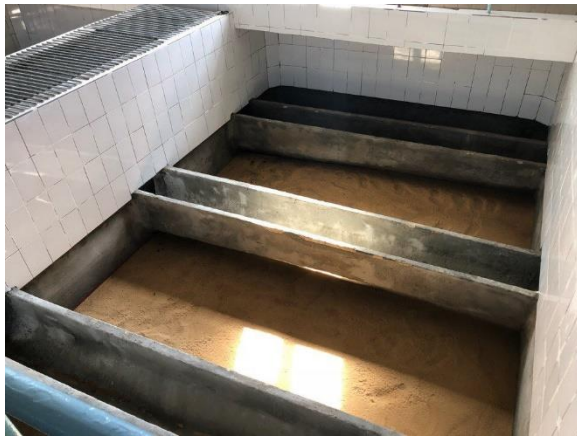
Рис. 2.35. Внешний вид скорых фильтров: а) зал скорых фильтров; б) коридор трубопроводов; в) вид на сборные желоба, загрузку и дренажную систему
