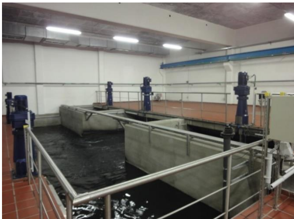
Рис. 1.5. Механические смесители и камера хлопьеобразования
