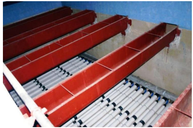
Рис. 2.35. Внешний вид скорых фильтров: а) зал скорых фильтров; б) коридор трубопроводов; в) вид на сборные желоба, загрузку и дренажную систему
