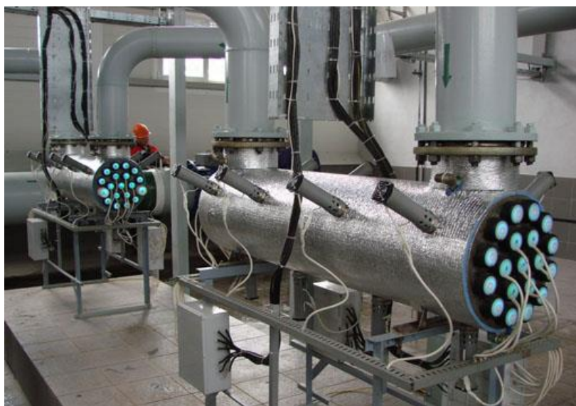
Рис. 2.52. Внешний вид бактерицидных установок «Лазурь-М».
