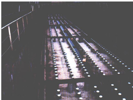
Рис. 6.9. Общий вид аэрационной системы с тарельчатыми диффузорами
