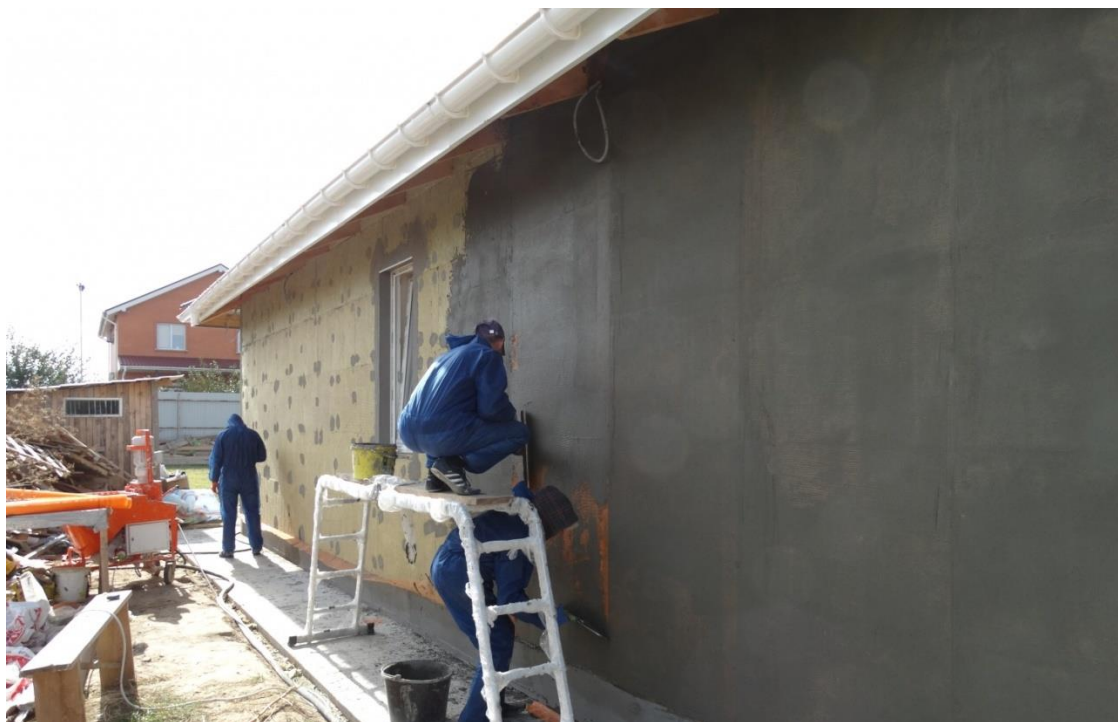
Рисунок 3.5. Штукатурка фасада по утеплителю
