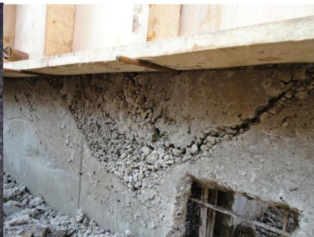
*Рис. 1.10. Раковины в железобетонных стенах*
