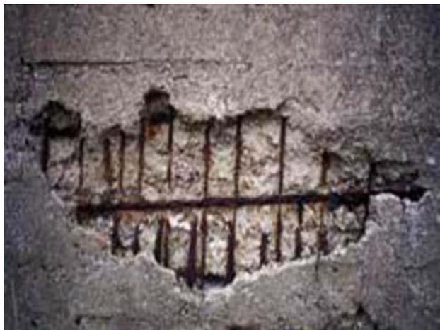
*Рис. 1.9. Выбоины и углубления в бетоне*
