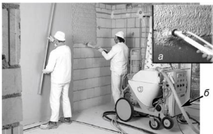
Рис. 3.6. Оштукатуривание стен механизированным способом с помощью мобильной штукатурной станции: а - форсунка в работе; б - шланг подачи сухой смеси из силоса
