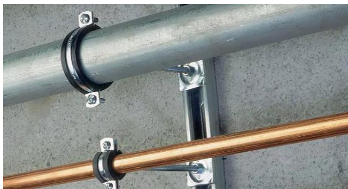
Рис.14 Крепление трубопроводов на жесткие держатели
