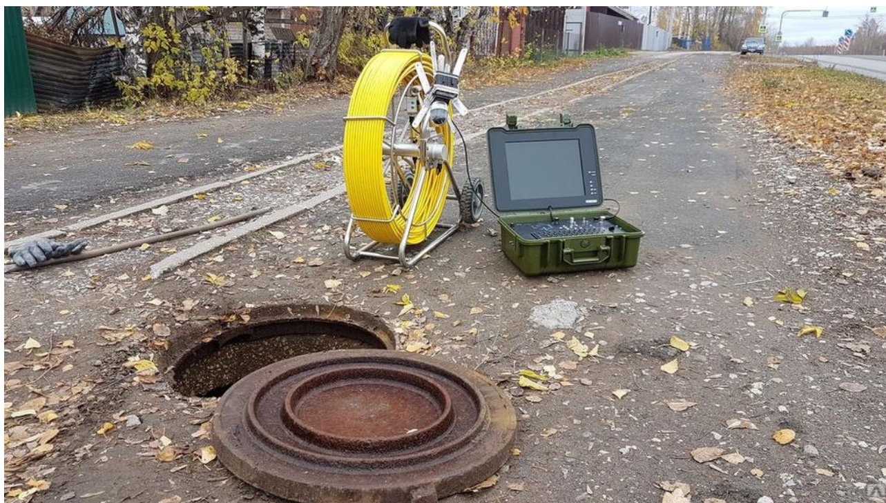
Рис.2.2. Видеодиагностика трубопроводов
