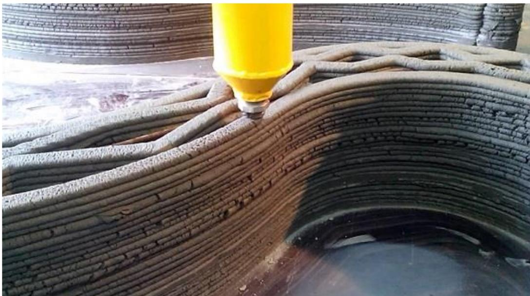
*Рис. 3.30 3D печать в строительстве (аддитивные технологии)*
