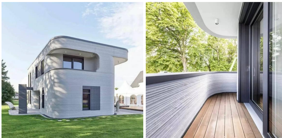
Рисунок 1.13. Первый жилой дом в Германии, полностью напечатанный на строительном принтере в 2021
