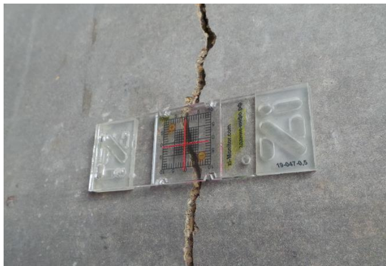
Рисунок 1. Пример установки пластинчатого маяка
