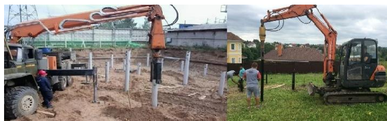
Рис. 3.30 Установка винтовых свай гидровращателем, установленным на кране (кране манипуляторе) и на мини экскаваторе
