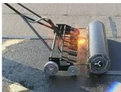
Рис. 4.11 Укладка рулонных гидроизолирующих материалов
