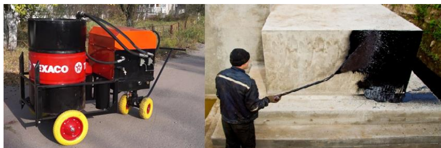
Рис. 12 Гудронатор и нанесение битумной эмульсии
