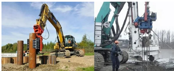
Рис. 3.28 Вибропогрузатели на базе экскаватора и крановый
