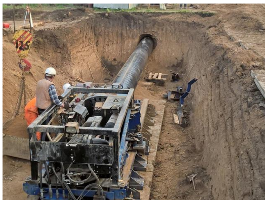
Рис. 3.34 Установка для продавливания трубы
