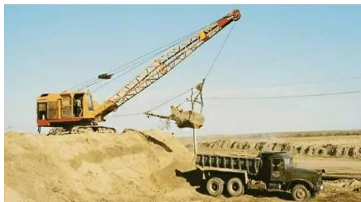
Рис. 3.11 Строительный экскаватор с рабочим оборудованием драглайн и погрузкой грунта в автосамосвал
