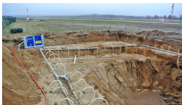
Рис. 3.7 Водопонижение и водоотведение
