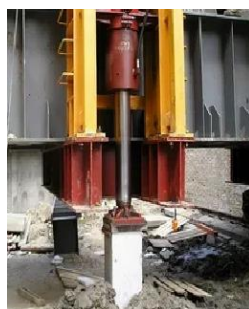
Рис. 3.29 Погружение готовых свай статическим вдавливанием
