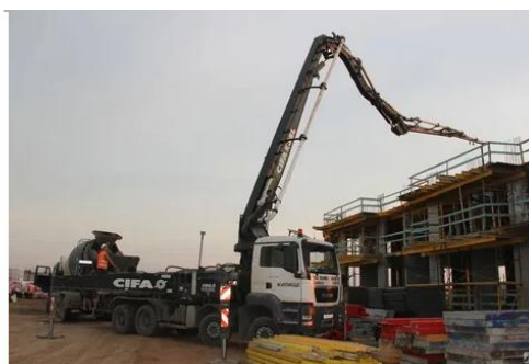
Рис. 4.7 Стационарный бетононасос и автобетононасос со стрелой-манипулятором
