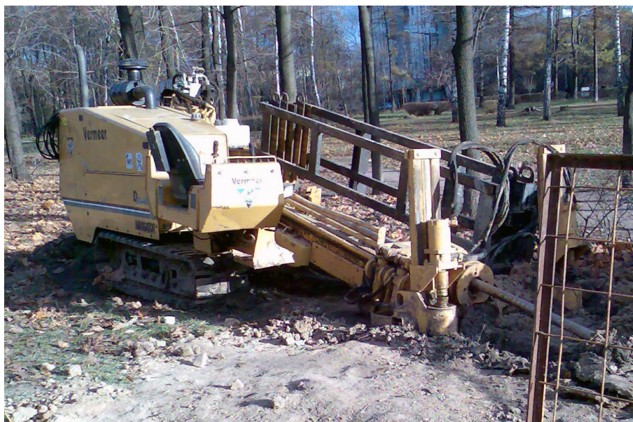
Рис. 4.10. Установка горизонтального направленного бурения.
