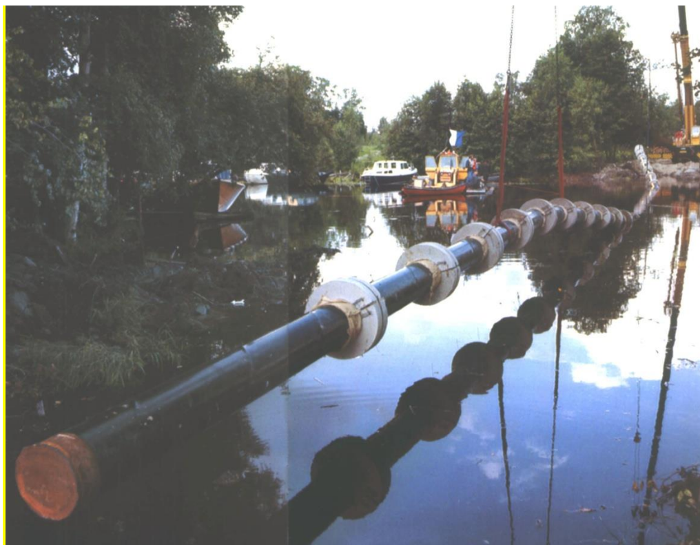
Рис. 3.18. Укладка стального дюкера на дно реки.
